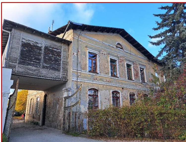
Rysunek 33. Zlokalizowany na obszarze rewitalizacji budynek komunalny w złym stanie technicznym
