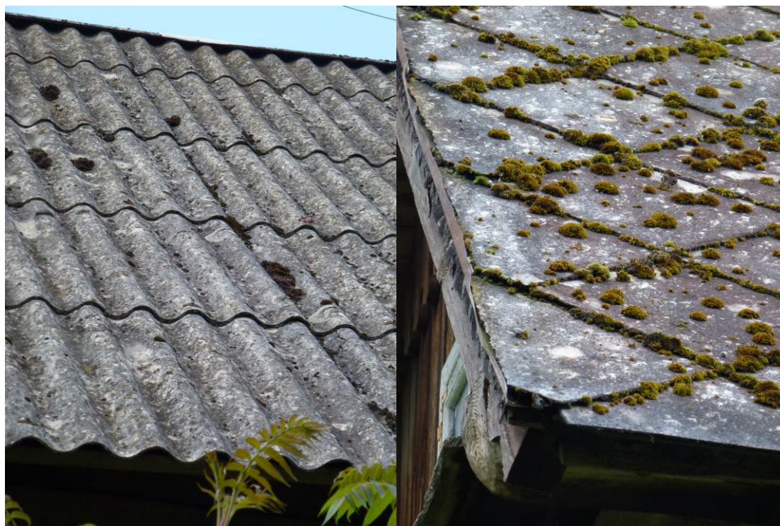
Rys. 1. Najpopularniejsze w Polsce wyroby azbestowo – cementowe: płyty faliste oraz romboidalne (Źródło: Fotografie własne)
