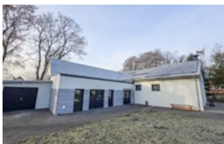
Rozbudowa i przebudowa budynku remizy OSP w Trzebowie – str. 3
