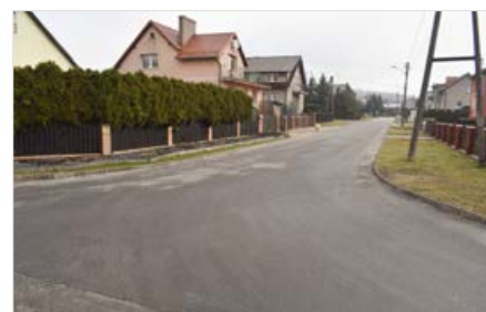
Remont dróg ul. Morelowa i ul. Malinowa – str. 5
