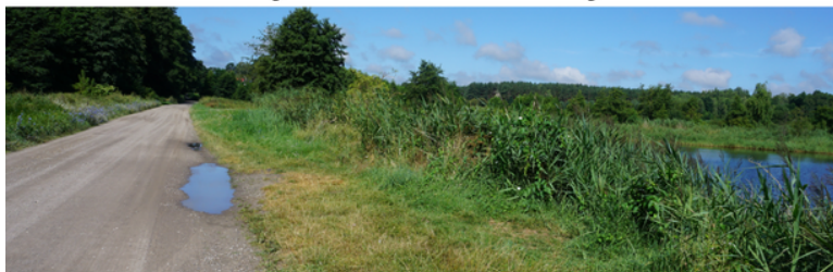
na realizację zadania "Przebudowa drogi gminnej 160902W (ul. Stary Trakt) Wólka Kocerańska - gr. gm. Pniewy - (Wysoczyn) na odcinku o długości 770,10 mb"
