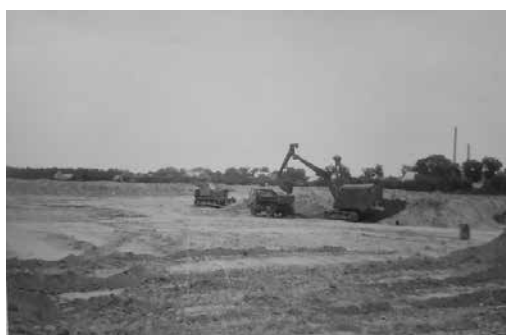
Rozpoczęcie budowy SP nr 3, rok 1988
