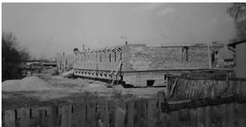
Stan budowy w 1985 roku.
