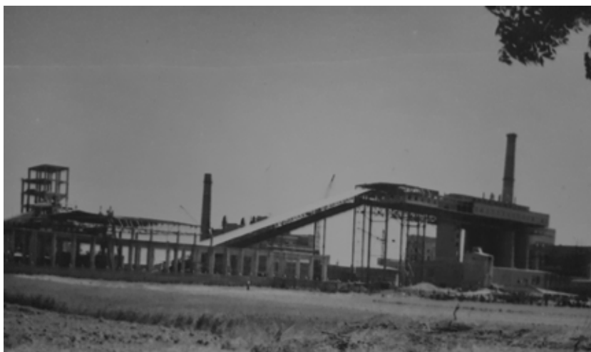
Panorama budowy zakładów sodowych.
