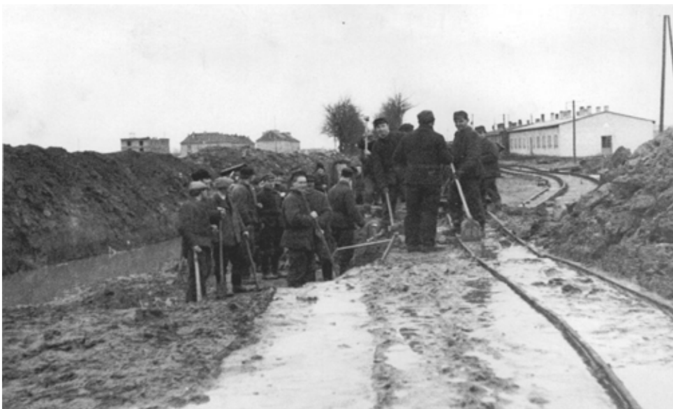
Przebudowa ul. Przemysłowej na początku lat 50. XX w. W tle widoczna budowa bloków przy ul. Wewnętrznej.
