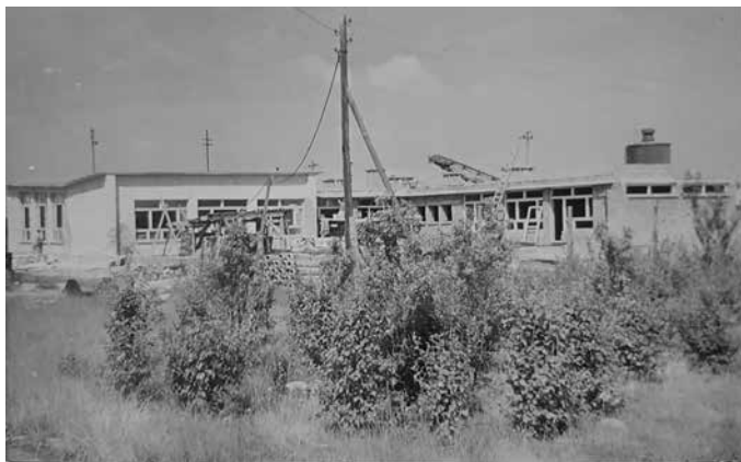
Budowa przedszkola zakładowego przy ul. Miłej w Janikowie, rok 1968.
