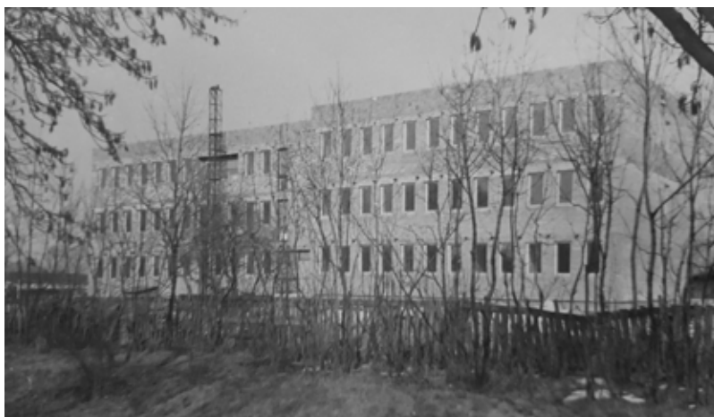
Budynek ratusza w stanie surowym, rok 1987.
