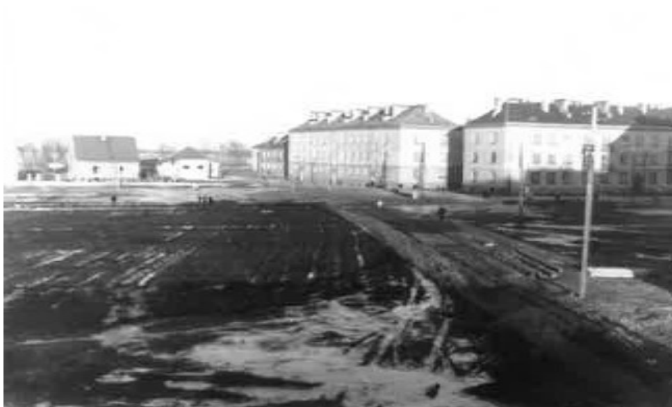
Widok na bloki przy ul. Północnej i ul. Słonecznej.
