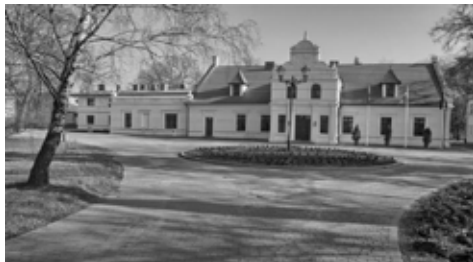
Pałac w Kołudzie Wielkiej
