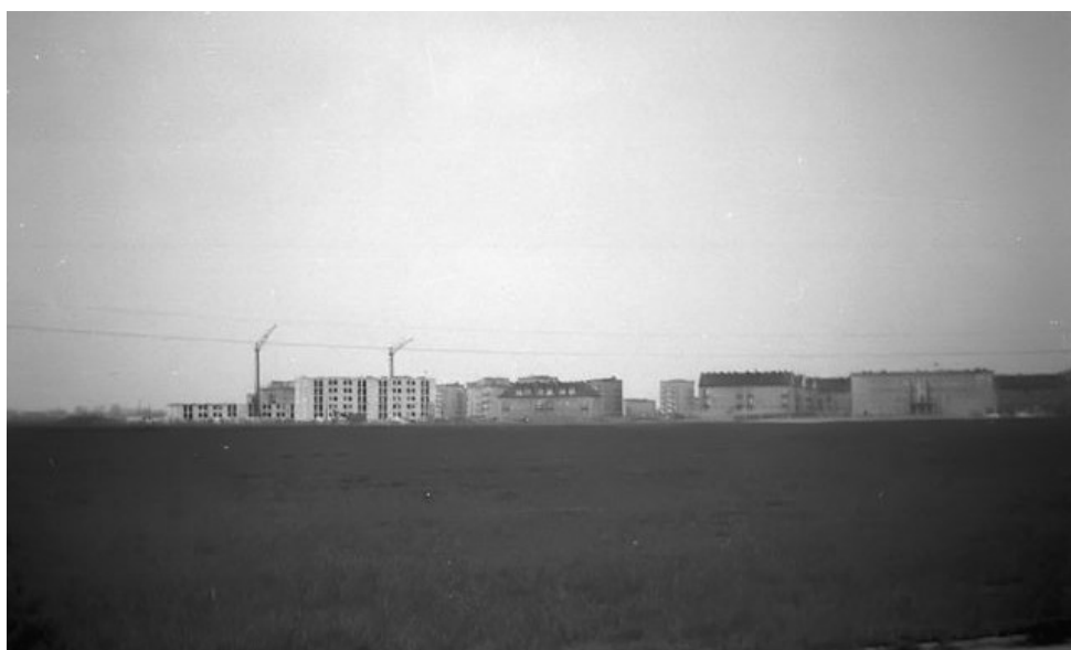
Budowa bloków K.S.M. przy ul. Ogrodowej, po prawej stronie Szkoła Podstawowa nr 2.
