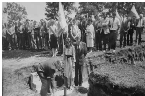
Rozpoczęcie budowy sali gimnastycznej przy SP nr 1 21 lipca 1987
