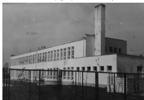
Ukończony budynek żłobka, rok 1979
