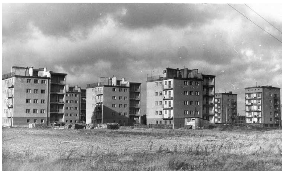
Bloki przy ul. Głównej.
