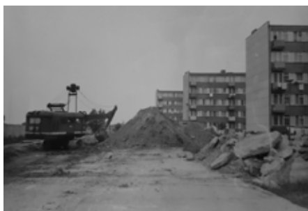
Budowa ul. Sportowej
