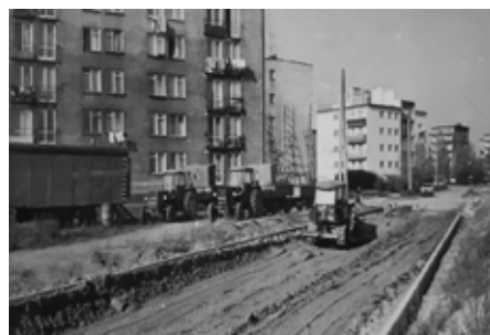
Budowa ul. Dworcowej
