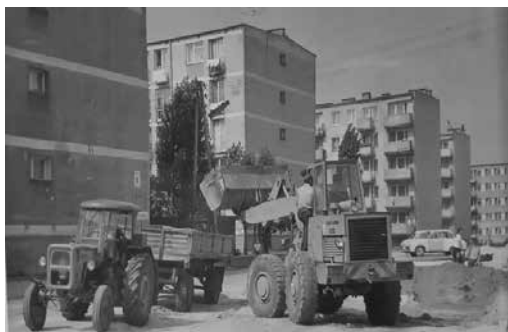
Budowa ul. Ogrodowej w Janikowie, rok 1983
