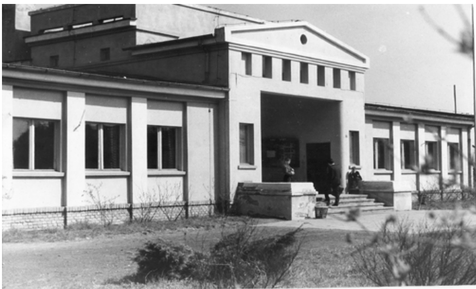
Budynek Zakładowego Domu Kultury z salą kinową wybudowany w 1957 roku.
