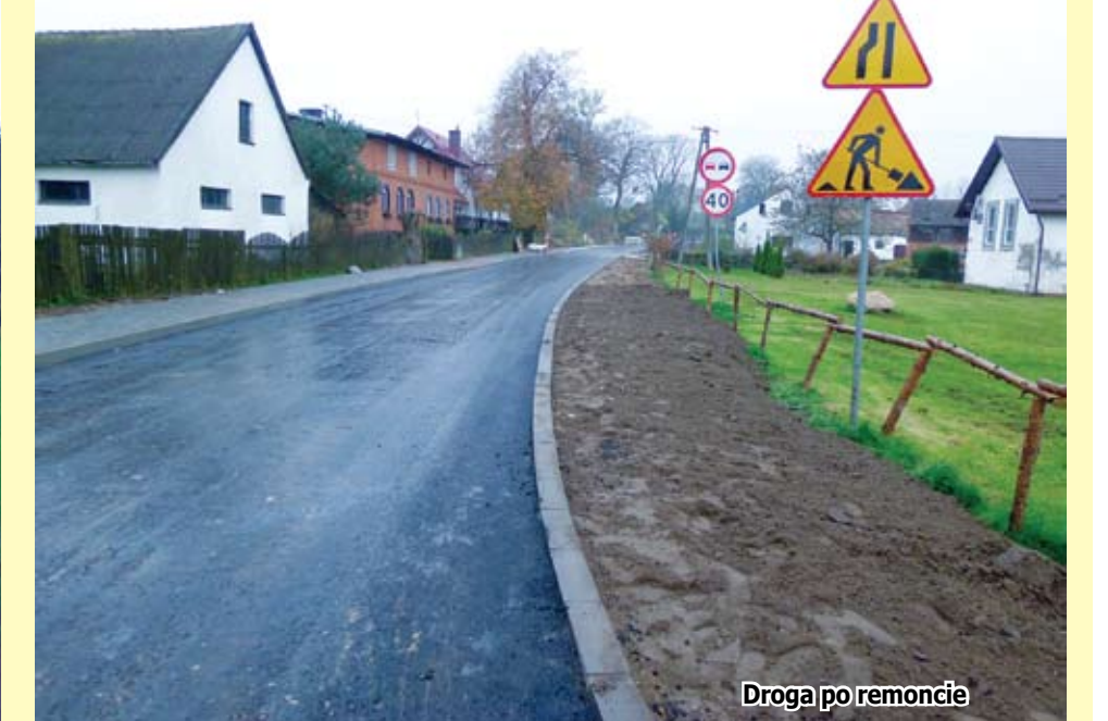
Droga po remoncie
