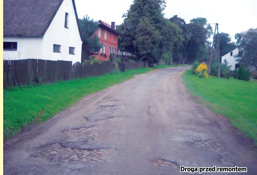
Droga przed remontem
