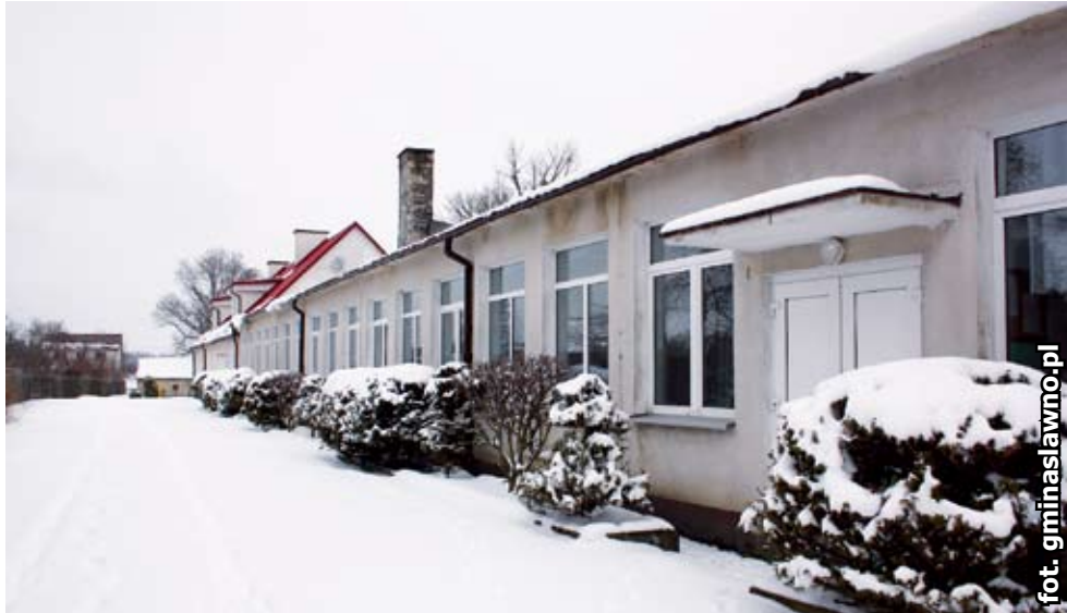
Budynek dawnej szkoły w Gwiazdowie
