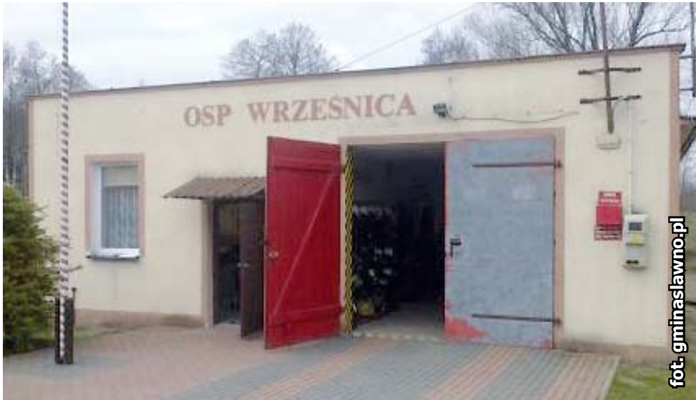
Budynek remizy OSP we Wrześnicy
