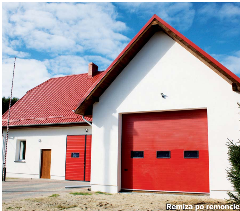
Remiza w trakcie remontu
