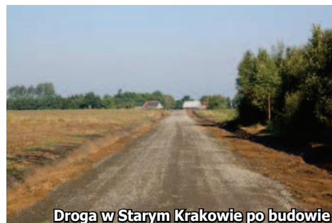
Droga w Starym Krakowie po budowie
