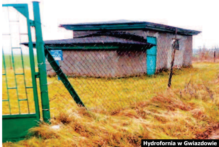
Hydrofornia w Gwiazdowie
