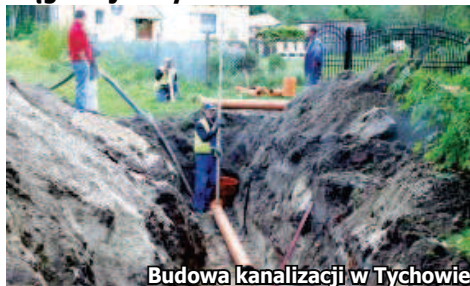
Budowa kanalizacji w Tychowie
