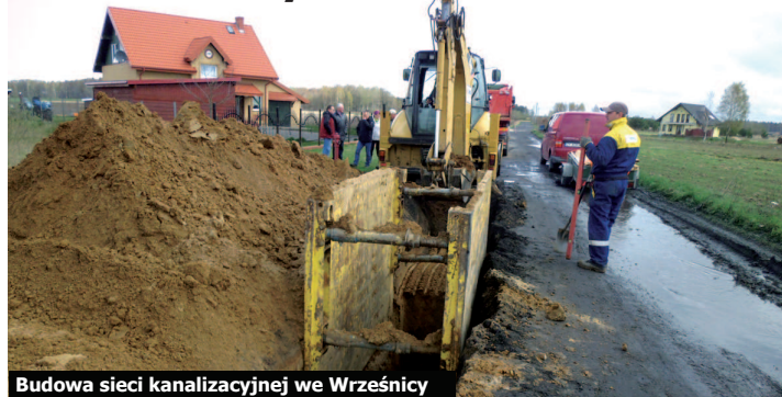
Budowa sieci kanalizacyjnej we Wrześnicy
