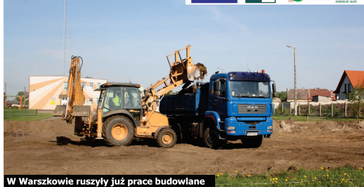
W Warszówku ruszyły już prace budowlane
