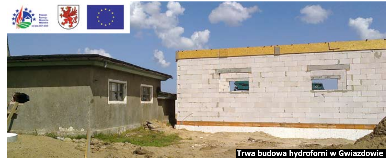
Trwa budowa hydroforni w Gwiazdowie
