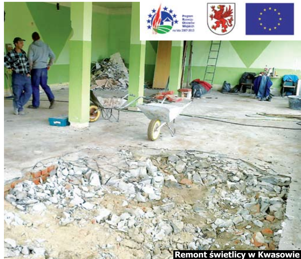
Remont świetlicy w Kwasowie
