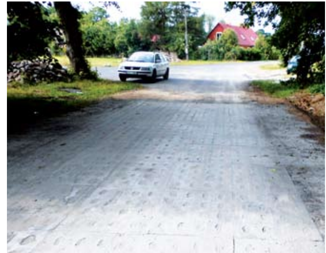
Wyremontowany odcinek drogi w Łętowie
