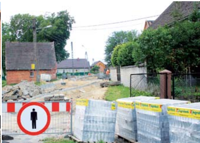
Przebudowa drogi gminnej w Sławsku
