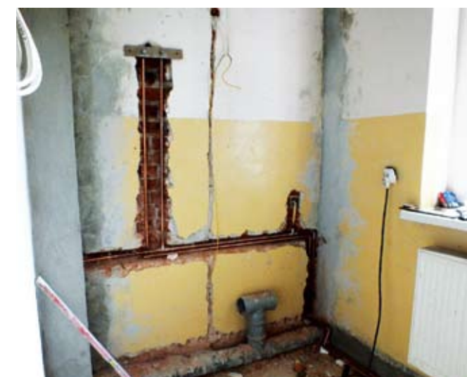
Nowe instalacje w pomieszczeniach SP Bobrowice
