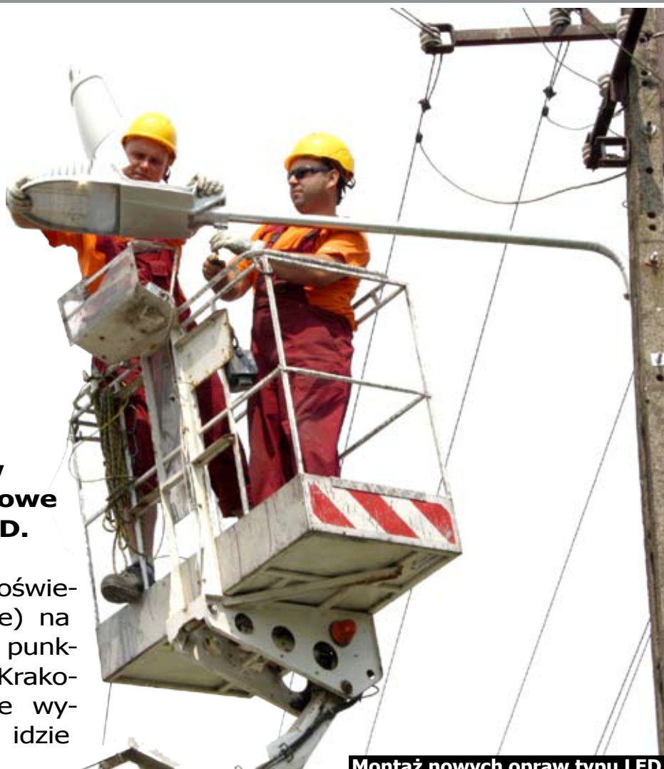
Montaż nowych opraw typu LED
