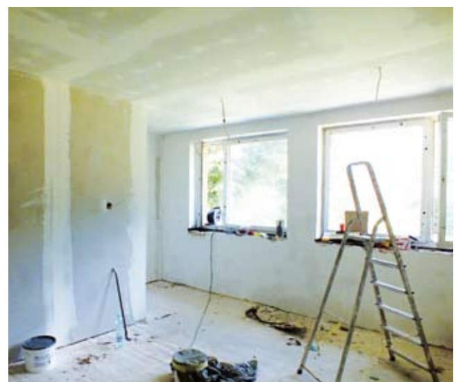
Adaptacja pomieszczeń na potrzeby przedszkola
