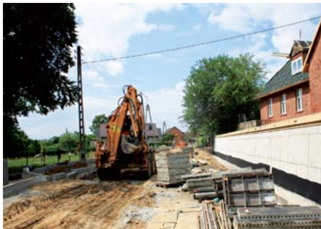
Ściana oporowa przy przedszkolu w Sławsku
