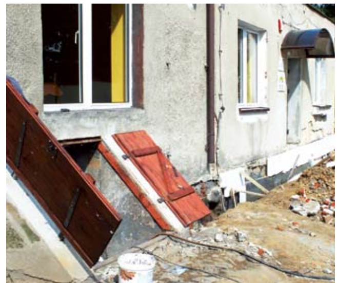
Izolacja fundamentów budynku
