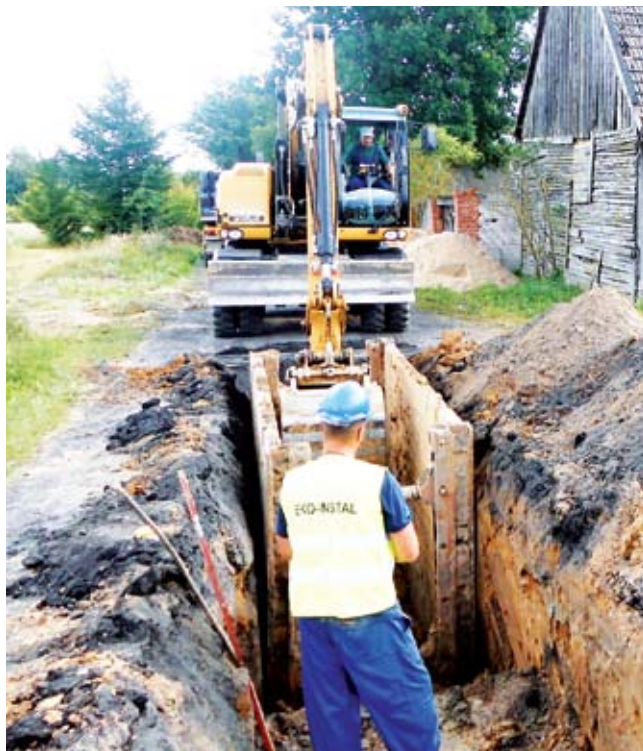
Podczas robót wykop zabezpieczano ściankami
