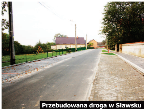
Przebudowana droga w Sławsku
