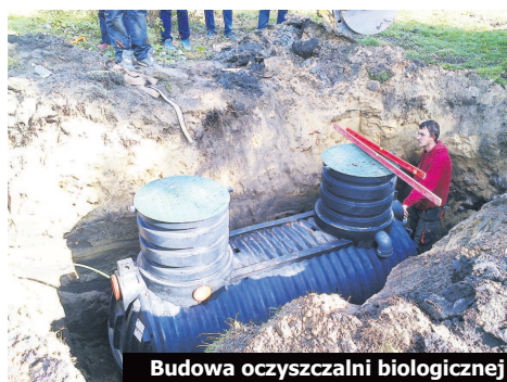
Budowa oczyszczalni biologicznej
