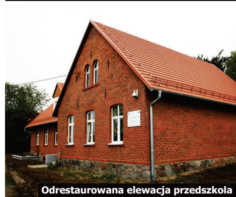
Odrestaurowana elewacja przedszkola
