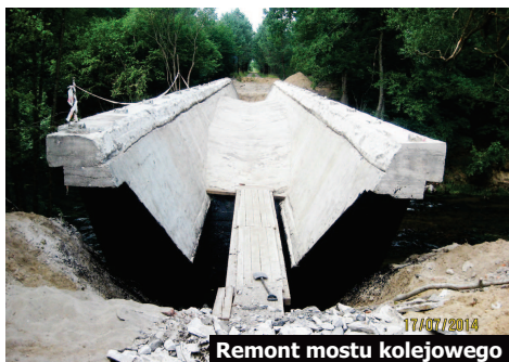
Remont mostu kolejowego
