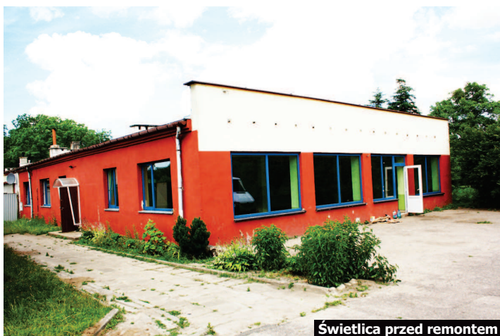
Świetlica przed remontem
