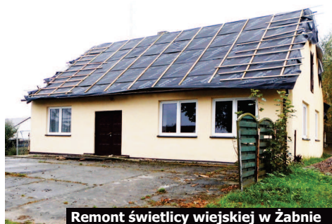
Remont świetlicy wiejskiej w Żabnie
