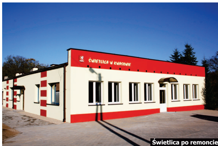
Świetlica po remoncie
