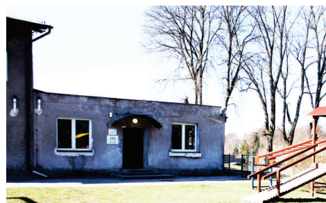
Elewacja Punktu Przedszkolnego przed remontem
