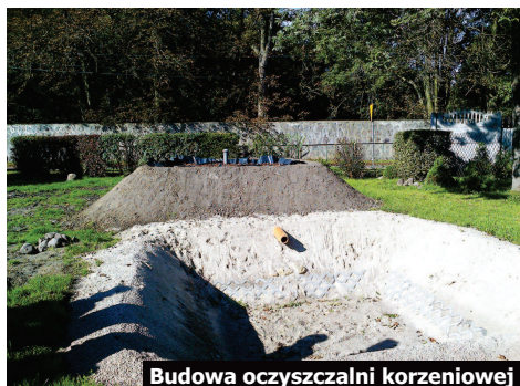
Budowa oczyszczalni korzeniowej
