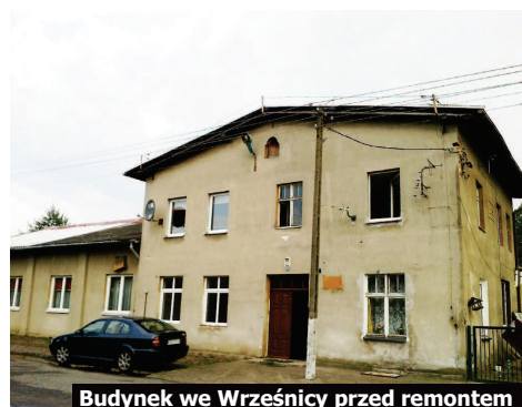
Budynek we Wrześnicy przed remontem
