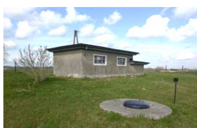
Budynek „starej” hydroforni w Gwiazdowie
