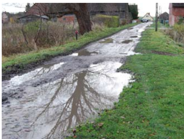
Droga przed modernizacją
