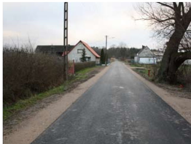
Nowa droga w Radosławiu
