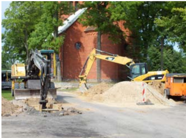
Budowa sieci kanalizacji sanitarnej we Wrześnicy
