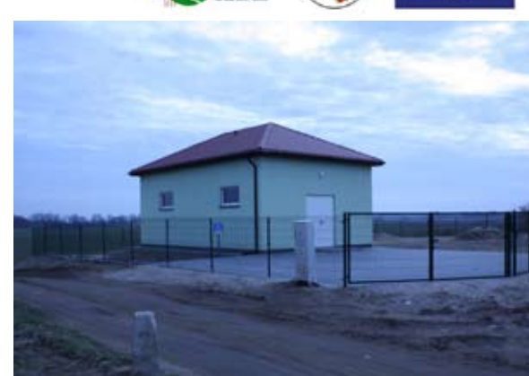
Hydrofornia w Gwiazdowie
