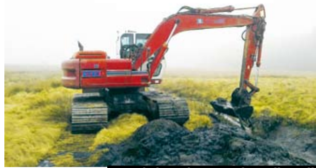
W trakcie wykonywania melioracji
