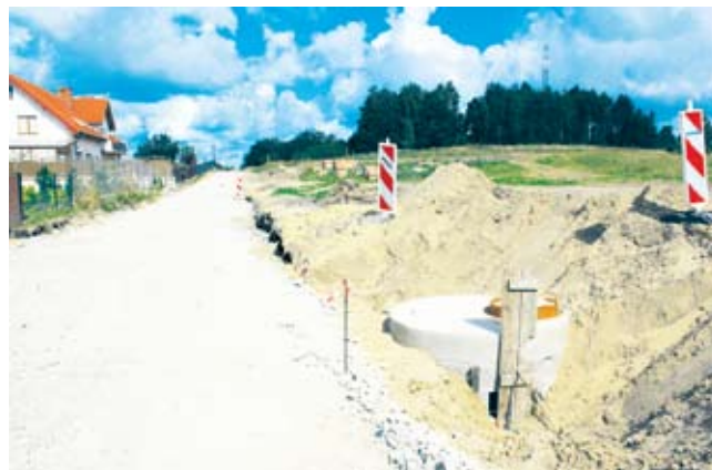
Wykonano korytowanie drogi i wybudowano studnie
