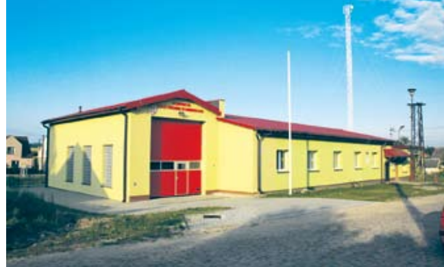
Remiza OSP i świetlica w Janiewicach
