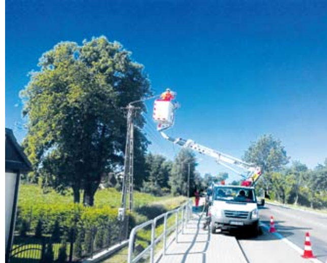
Montaż nowoczesnego oświetlenia drogowego
