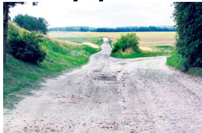
Niebawem wykonawca rozpocznie prace na drodze prowadzącej do Przybyłowa
