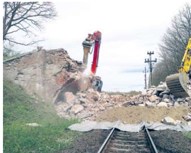
Wyburzono wiadukt nad torami
