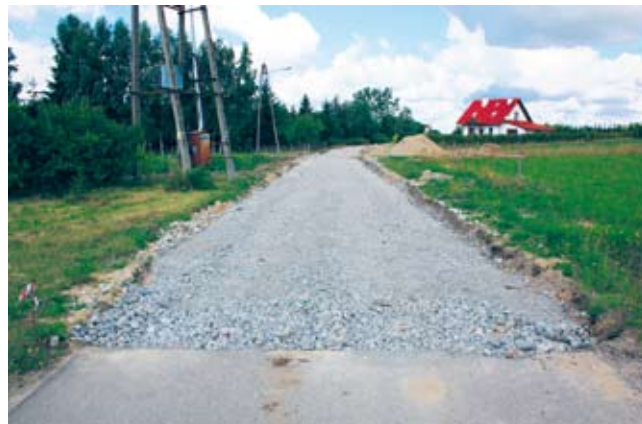
Podbudowa kolejnego odcinka schetynówki w Warszkwowie
