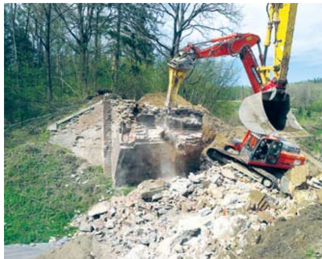
Nieczynny wiadukt w Sławsku został rozebrany
