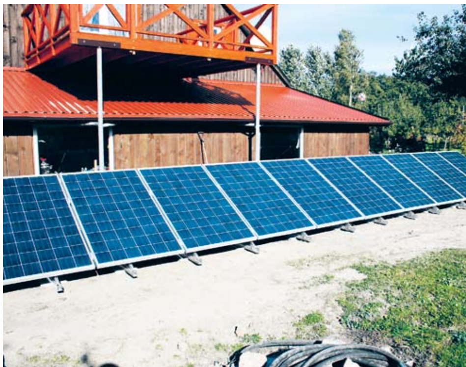
Panele usadowione na konstrukcjach metalowych ustawionych bezpośrednio na gruncie
