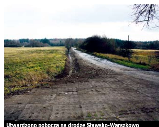
Utwardzono pobocza na drodze Sławsko-Warszkowo
