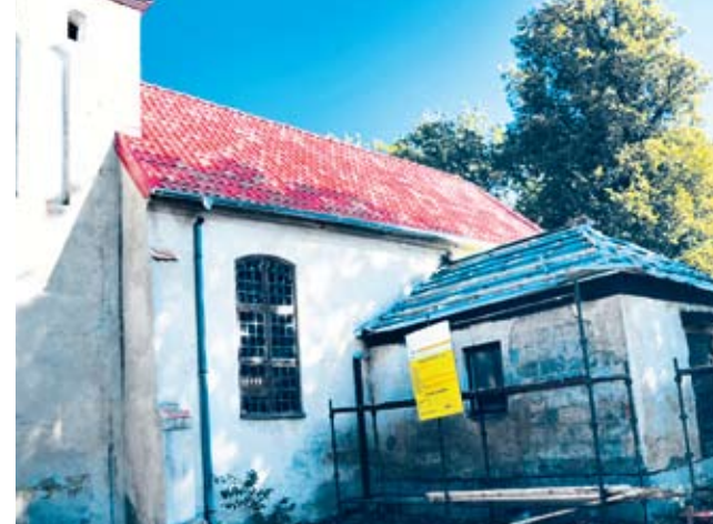
Remont kościoła w Kwasowie
