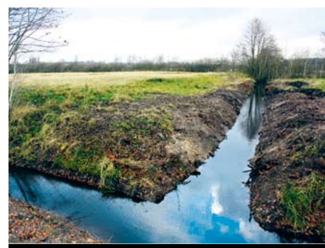
Odtworzone rowy odwadniające
