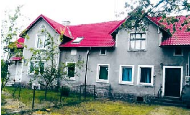
Budynek byłej przychodni we Wrześnicy przed remontem
