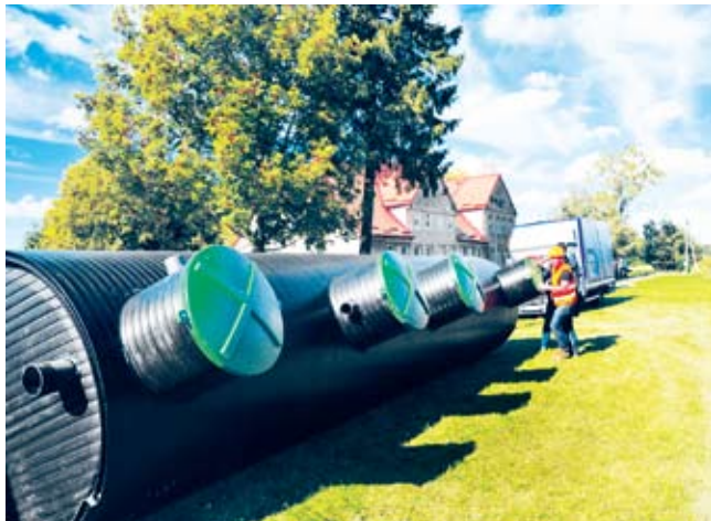
Budowa oczyszczalni biologicznej przy Filii Przedszkola Gminnego w Boleszewie
