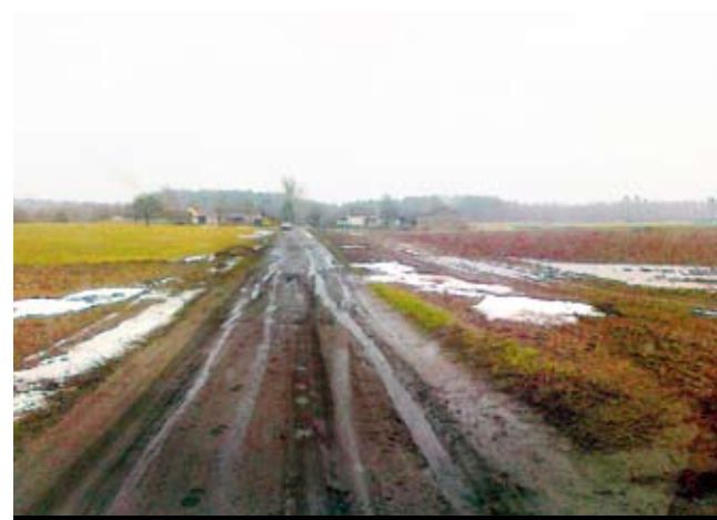
Droga przed modernizacją
