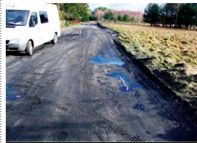
Droga przed przebudową
