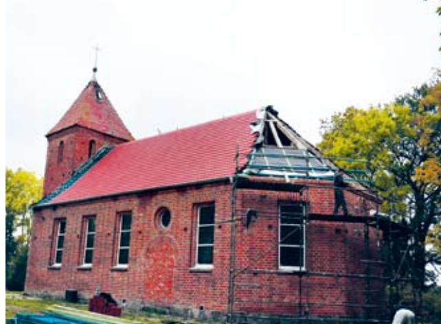
Wymiana pokrycia dachowego na kościele w Boleszewie
