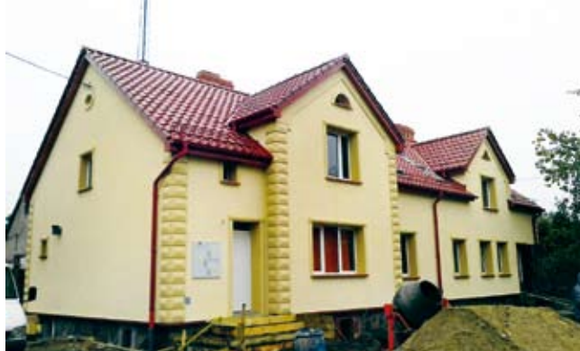
W trakcie wykonywania prac we Wrześnicy
