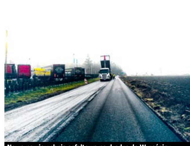
Nowa nawierzchnia asfaltowa na drodze do Wrześnicy
