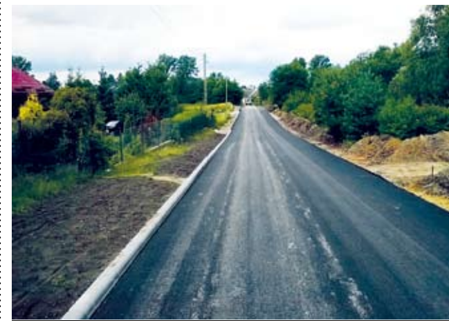
Nawierzchnia asfaltowa na drodze w Warszkwie
