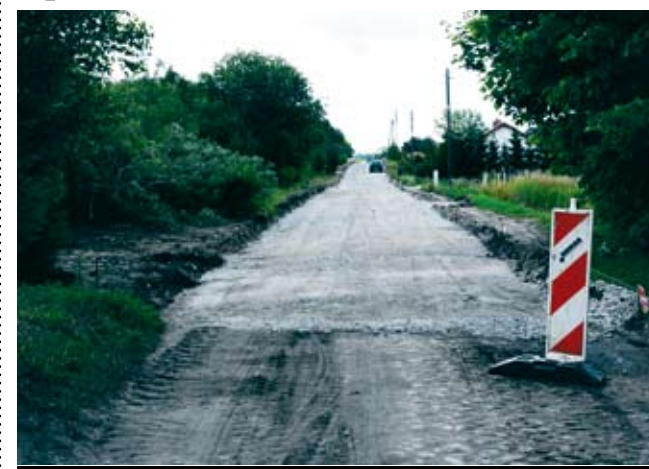
Początek robót budowlanych
