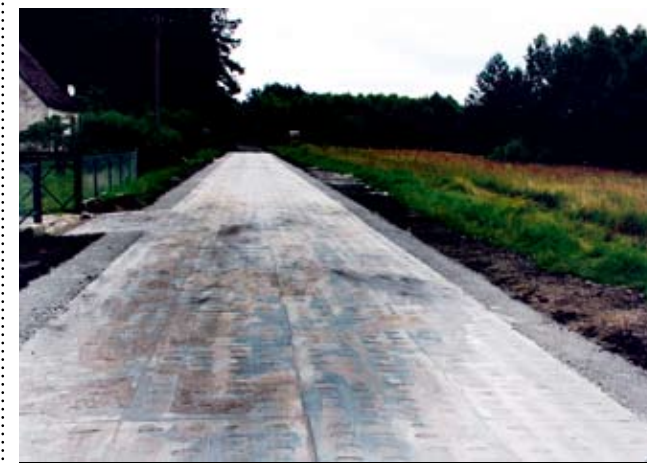
Płyty betonowe na drodze dojazdowej do Jeziora Łętowskiego
