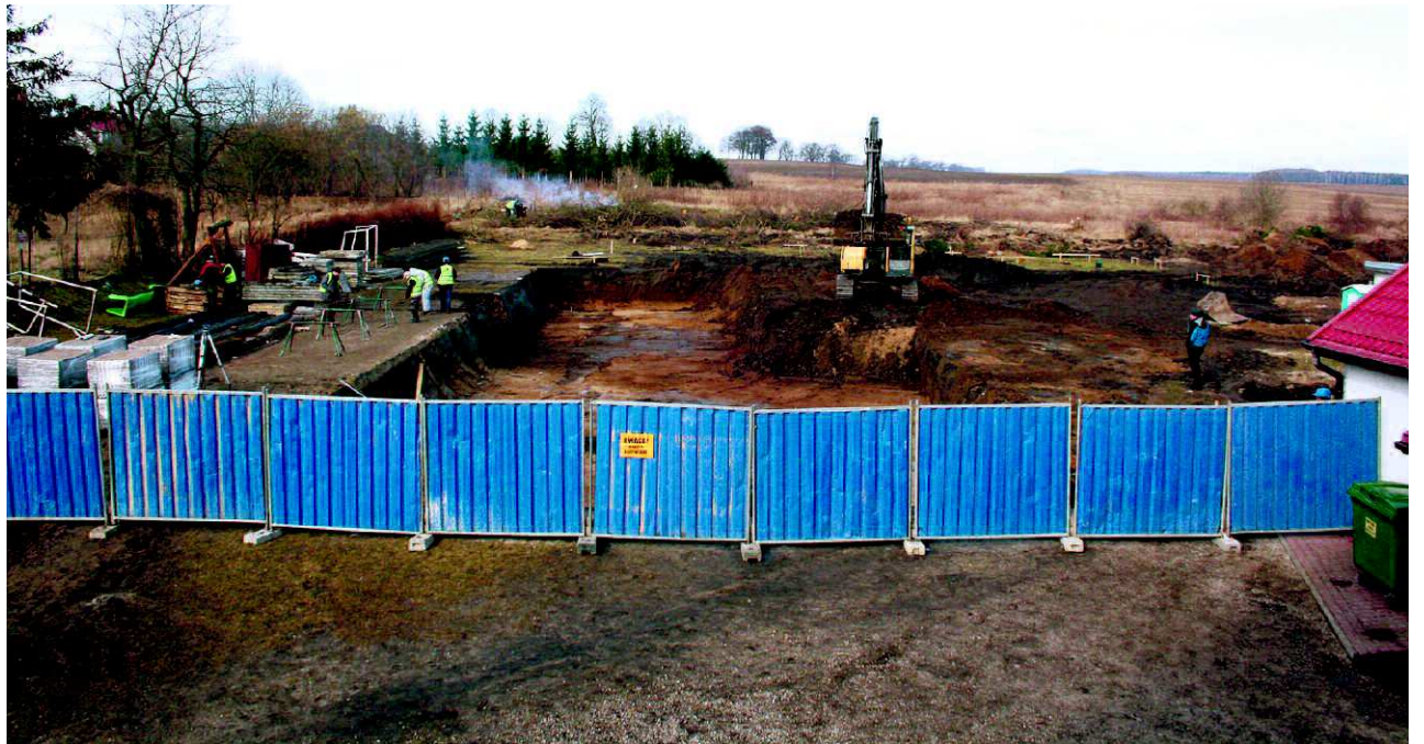
PIERWSZE ROBOTY PRZY BUDOWIE SZKOŁY W ŻUKOWIE
