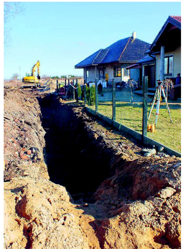
■ POWSTAJE WODOCIĄG I KANALIZACJA W NOSKOWIE
