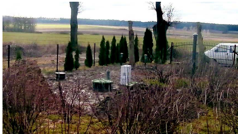
JEDNA Z 19 NOWYCH OCZYSZCZALNI ŚCIEKÓW
