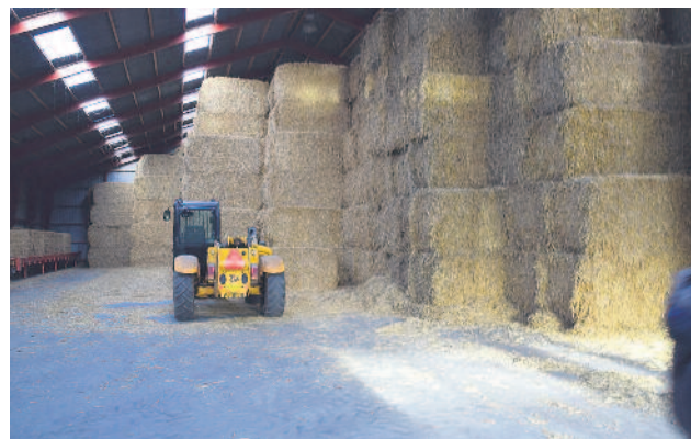
Magazyn słomy przy lokalnej ciepłowni w Samsø
