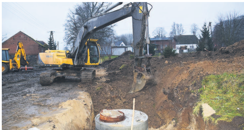
■ TRWAJĄ PRACE PRZY BUDOWIE KANALIZACJI
