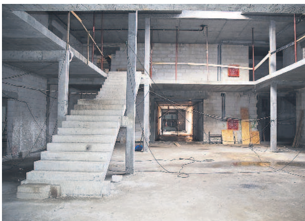
■ HOL BUDOWANEJ SZKOŁY W ŻUKOWIE
