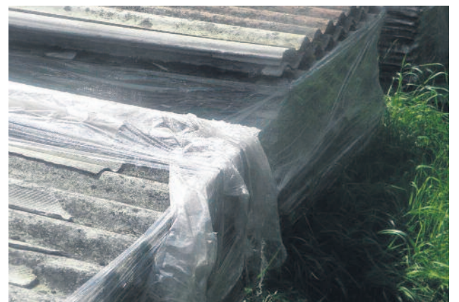
PRZYGOTOWANY DO WYWIEZIENIA I UTYLIZACJI AZBEST
