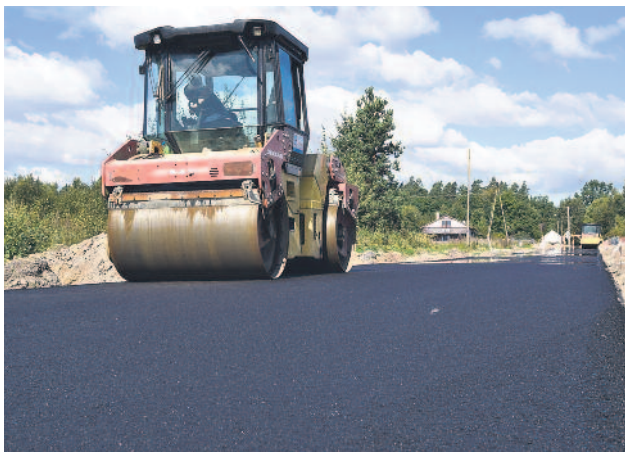
■ BUDOWA DROGI GMINNEJ W TOKARACH
