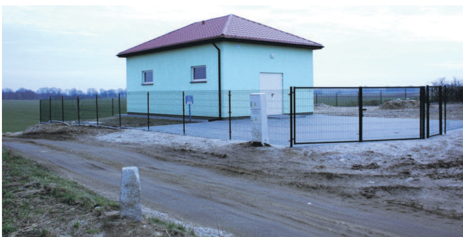
HYDROFORNIA W GWIAZDOWIE
