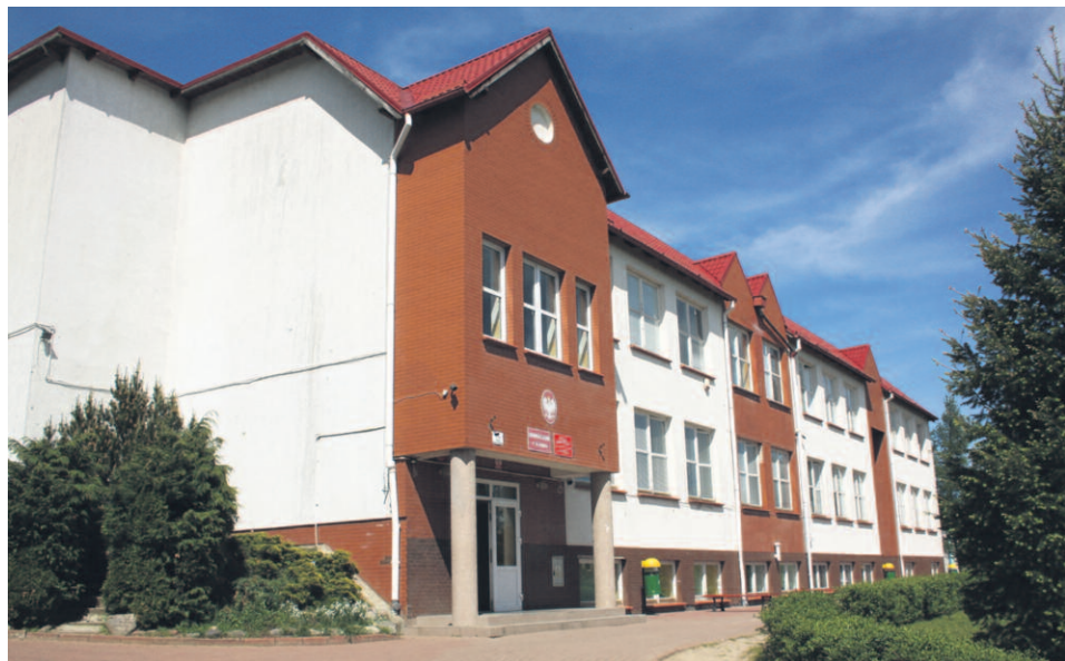
Budynek Zespołu Szkół w Sławsku (nie dokończona budowa II i III etapu)
