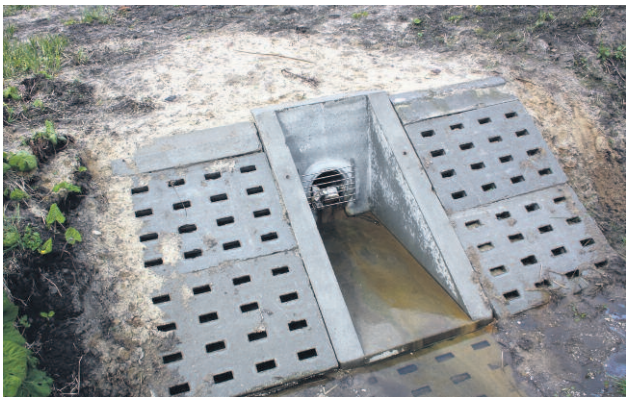
KANALIZACJA DESZCZOWA W ŻUKOWIE
