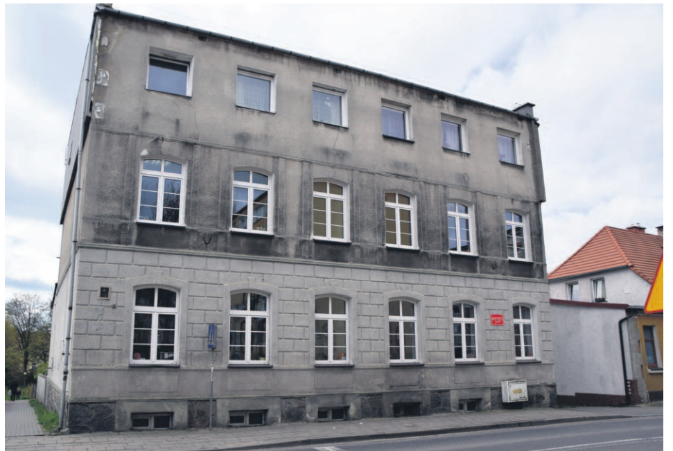
■ NOWA SIEDZIBA GOPS – UL. GDAŃSKA 18A
