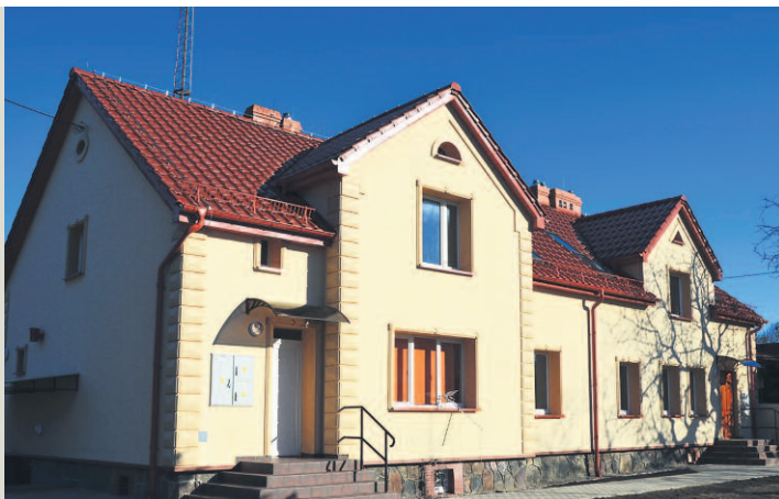
BUDYNEK WE WRZEŚNICY WCHODZĄCY W SKŁAD ZASOBU MIESZKANIOWEGO GMINY SŁAWNO
