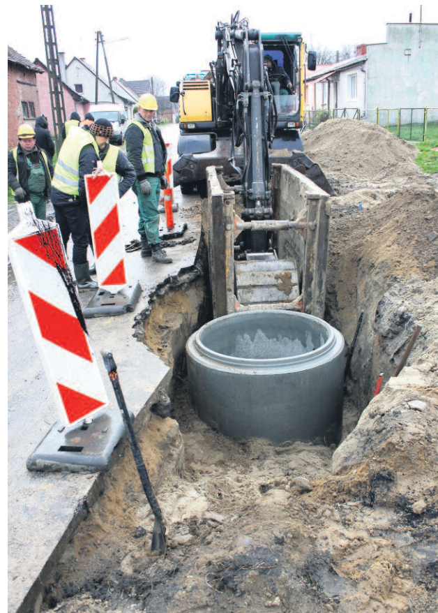
WZDŁUŻ DROGI GMINNEJ BUDOWANA JEST NOWA SIĘĆ WODOCIĄGOWA.
