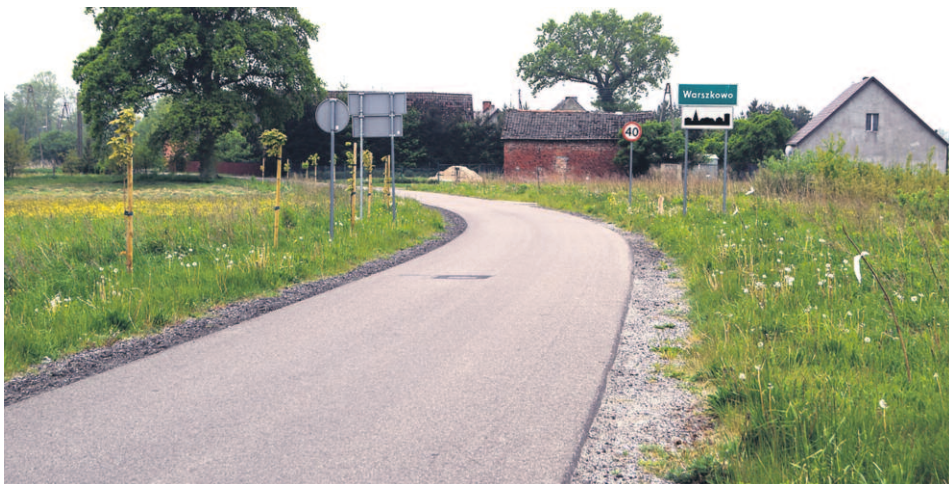
DROGA GMINNA W WARSZKOWIE
