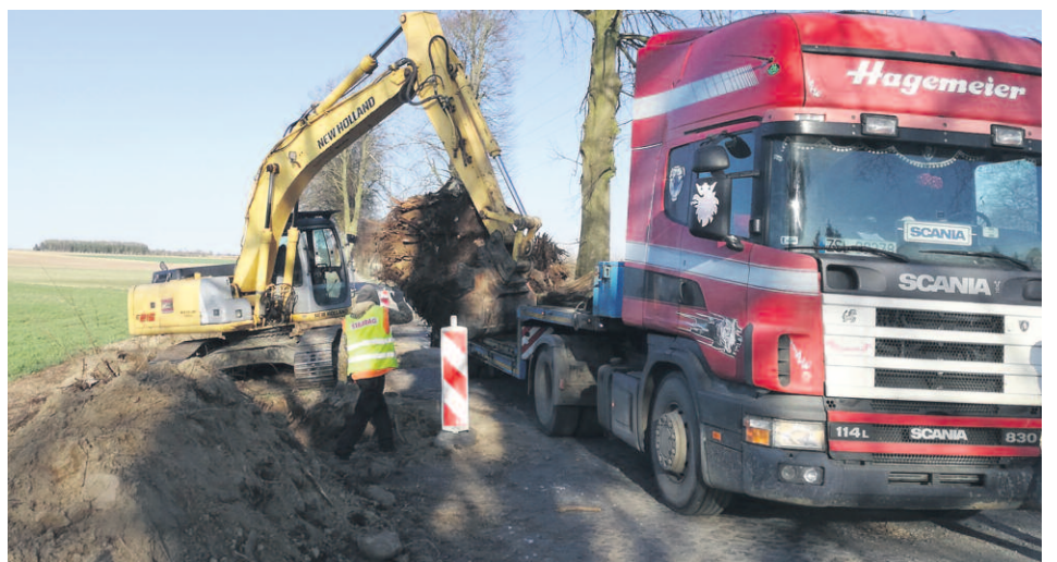
■ PRACE PRZY USUWANIU KARPIN PRZY DRODZE DO WARSZÓWKI
