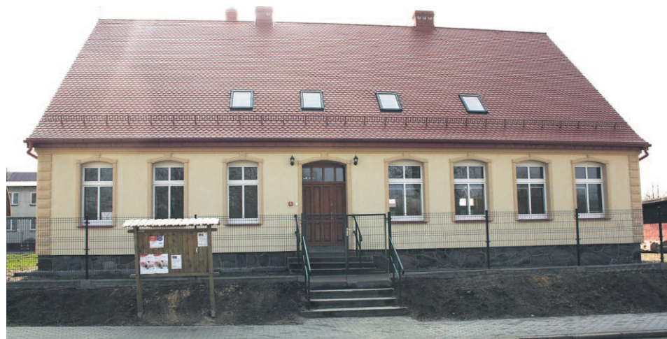
WYREMONTOWANA ŚWIETLICA W TYCHOWIE
