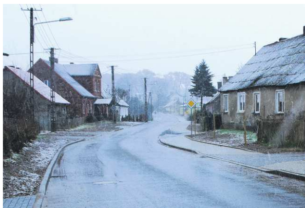
■ NOWA NAWIERZCHNIA ASFALTOWA DROGI WE WSI
