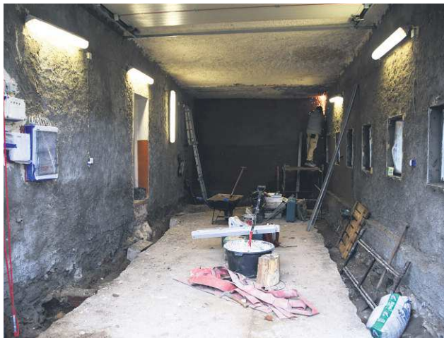
■ W TRAKCIE REMONTU W JANIEWICACH
