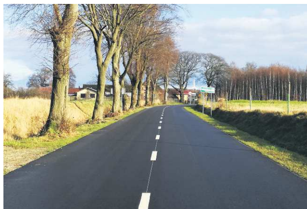
■ NOWA NAWIERZCHNIA ASFALTOWA I NASADZENIA PRZYDROŻNE
