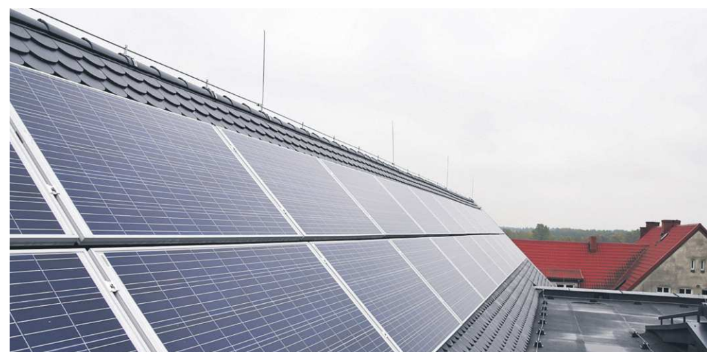
■ KILKADZIESIĄT PANELI FOTOWOLTAICZNYCH ZAINSTALOWANO NA DACHU SZKOŁY
