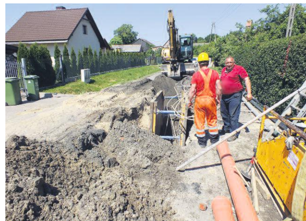
■ BUDOWA WODOCIĄGU I SIECI KANALIZACYJNEJ W SŁAWSKU
