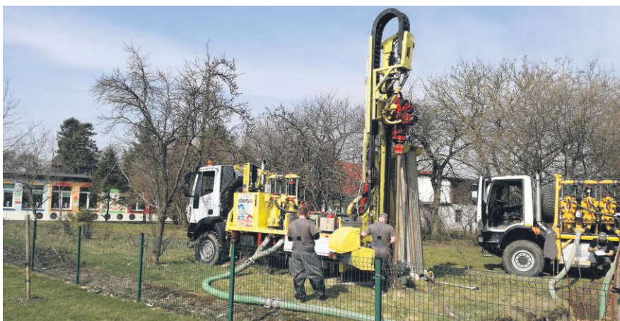
■ 100 METROWE ODWIERTY POD SONDY GRUNTOWE W GWIAZDOWIE
