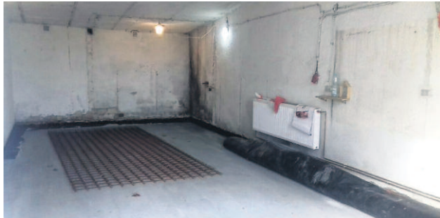
■ REMONTOWANY GARAŻ OSP GWIAZDOWO
