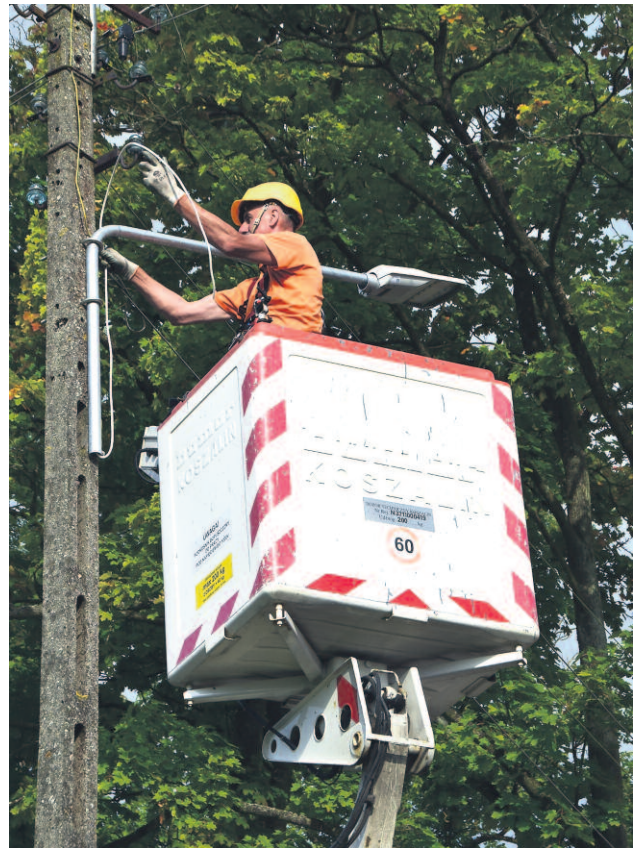
■ Montaż nowoczesnych opraw oświetleniowych LED we Wrześnicy. Markowe oprawy LED są 4 razy lżejsze od dotychczas stosowanych i mają moc 43 W
