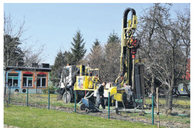
SONDY GŁĘBINOWE UMIESZCZONE ZOSTAŁY NA GŁĘBOKOŚCI 100 M, DZIĘKI SPECJALNIE WYKONANYM ODWIERTOM
