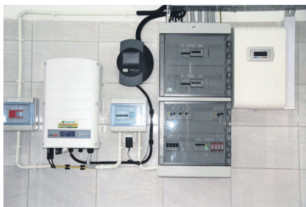
SKOMPLIKOWANE MODUŁY ELEKTRONICZNE STERUJĄ PRACĄ KOTŁOWNI
