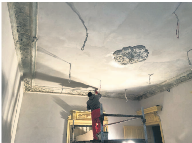
■ OSTROŻNOŚCI I PRECYZJI WYMAGAJĄ PRACE BUDOWLANE
