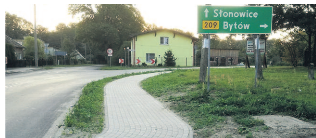
NOWY CHODNIK WZDŁUŻ DROGI WOJEWÓDZKIEJ W TYCHOWIE
