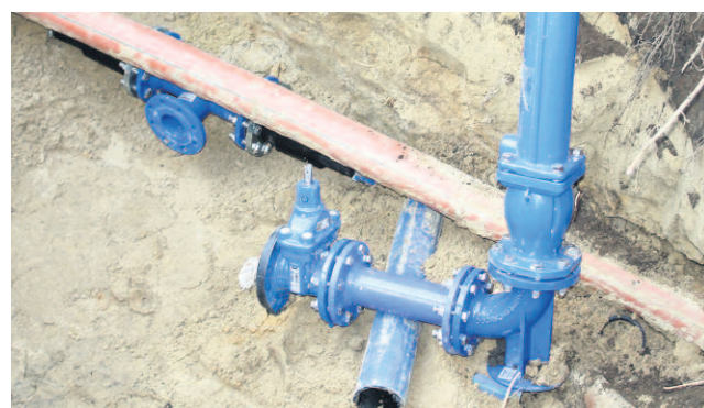
POWSTAJE SIĘĆ WODOCIĄGOWA I KANALIZACYJNA W SŁAWSKU
