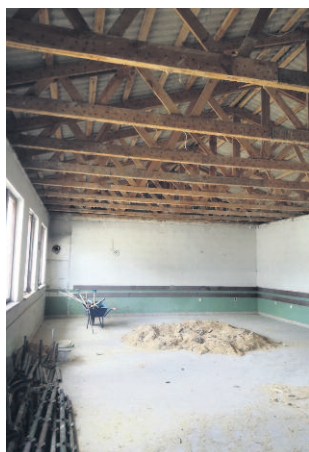
■ WYMIENIONO POKRYCIE DACHU, WYKONANO WYLEWKI
