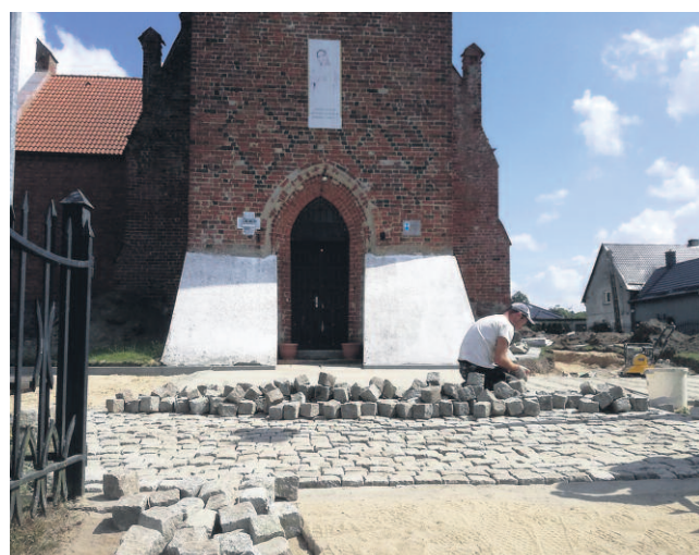
W TRAKCIE UKŁADANIA BRUKU
