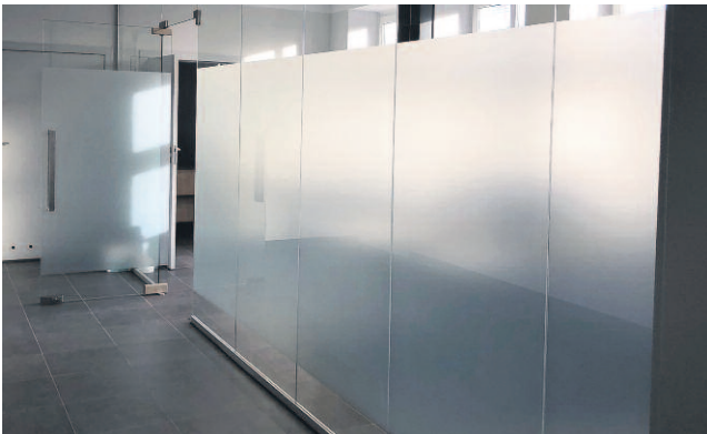
PRZESZKLONA ŚCIANA ODDZIELA CZĘŚĆ ADMINISTRACYJNĄ
