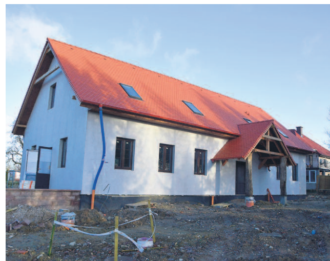
W TRAKCIE BUDOWY ŚWIETLICY WIEJSKIEJ W RADOSŁAWIU
