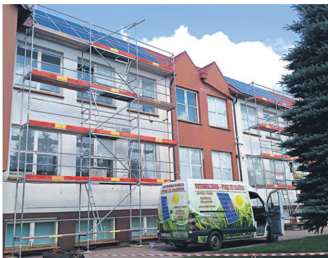
PANELE FOTOWOLTAICZNE ZAMONTOWANO NA DACHU SZKOŁY
