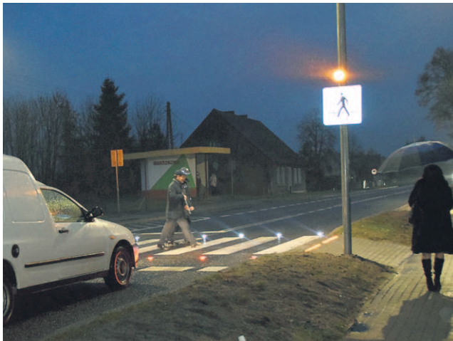
■ ŚWIATŁA – PULSACYJNE NA JEZDNI, NAD ZNAKIEM ORAZ DOŚWIETLENIE PASÓW ZWIĘKSZAJĄ BEZPIECZEŃSTWO PIESZYCH
