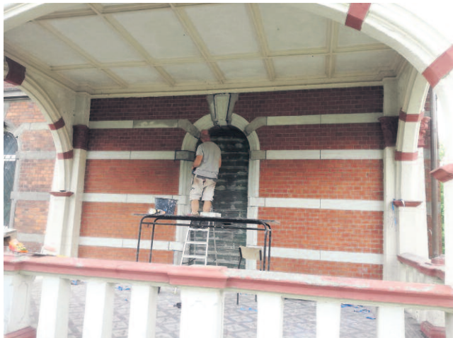
■ ODTWARZANE SĄ DETALE ARCHITEKTONICZNE
