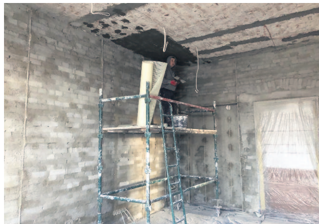
■ OCIEPLONE ŚCIANY, NOWE SIECI POZWOLĄ NA FUNKCJONOWANIE URZĘDU W ZABYTKOWEJ WILLI SCHULTZ'A
