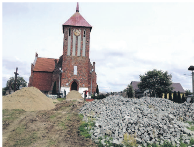
PRZYGOTOWANIA DO PRAC
