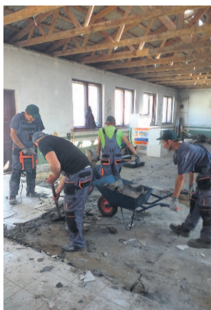
■ PRACE ROZBÓRKOWE WYKONANO W RAMACH WARSZTATÓW CIS
