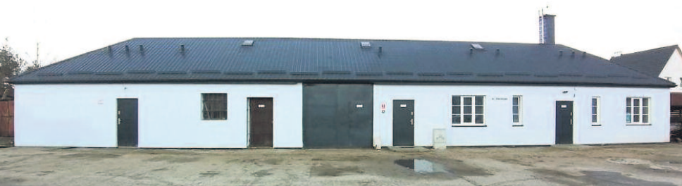
■ SIEDZIBA SPÓŁDZIELNI SOCJALNEJ KOMUNALKA NA UL. POLANOWSKIEJ W SŁAWNIE PO REMONCIE
