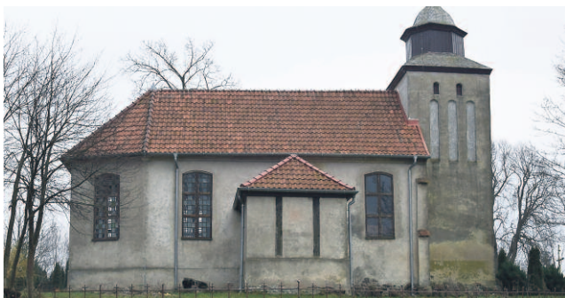
PRZED I PO REMONCIE KOŚCIOŁA W KWASOWIE
