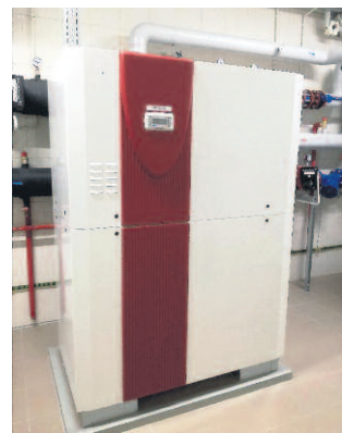
POMPY CIEPŁA W NOWOCZESNEJ KOTŁOWNI
