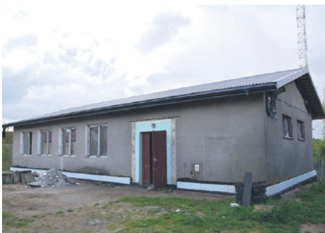
Kompleksowy remont i termomodernizacja świetlicy w Warszkówku
