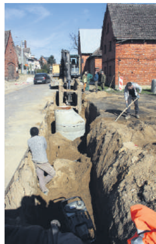
Prace ziemne przy budowie kanalizacji w Sławsku
