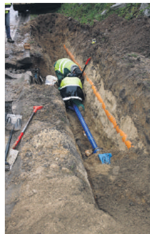
Ułożono nową sieć wodociągową
