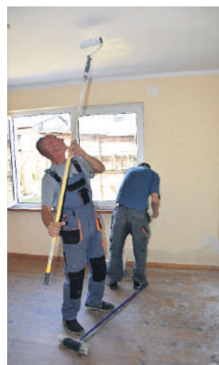
Warsztaty remontowo-budowlane w starej świetlicy w Radosławiu
