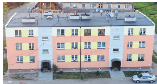
Zrewitalizowany w roku 2019 budynek wielolokalowy w Rzyszczewie
