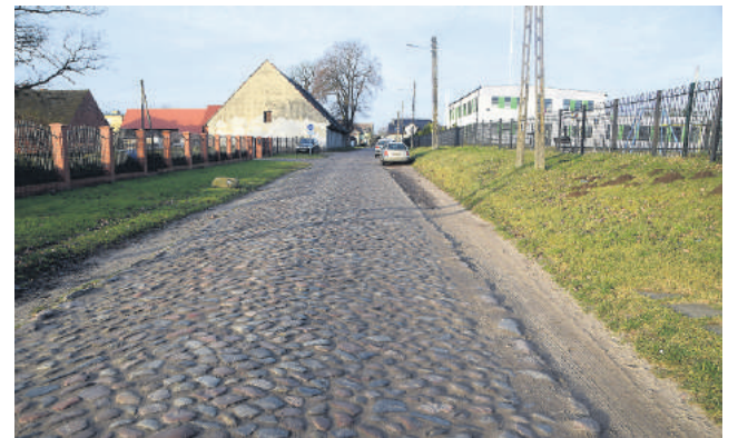
Ulica Szkolna w Warszkwie zostanie przebudowana
