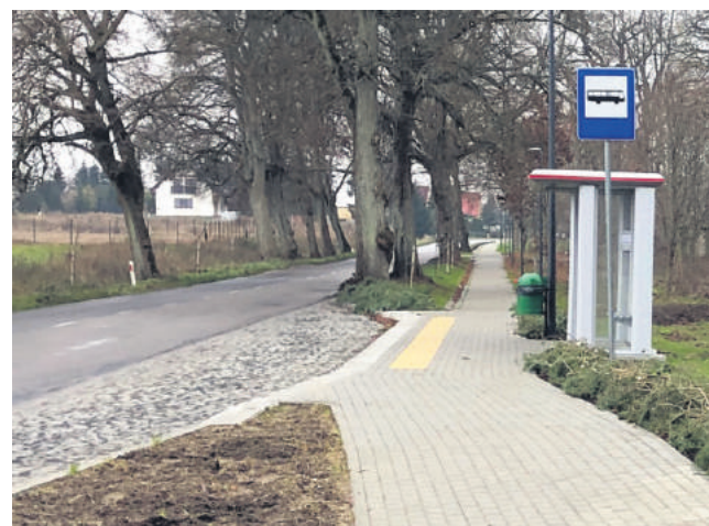
W Kwasowie powstała też zatoka autobusowa
