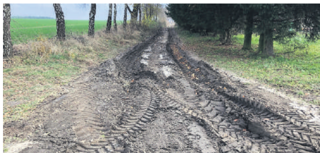
Stan drogi przed rozpoczęciem prac
