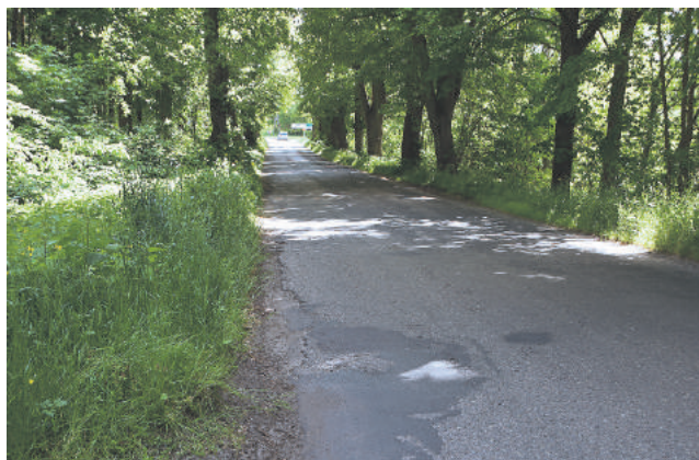
Wjazd do Tychowa od strony Warszowa - przed i po przebudowie drogi wojewódzkiej
