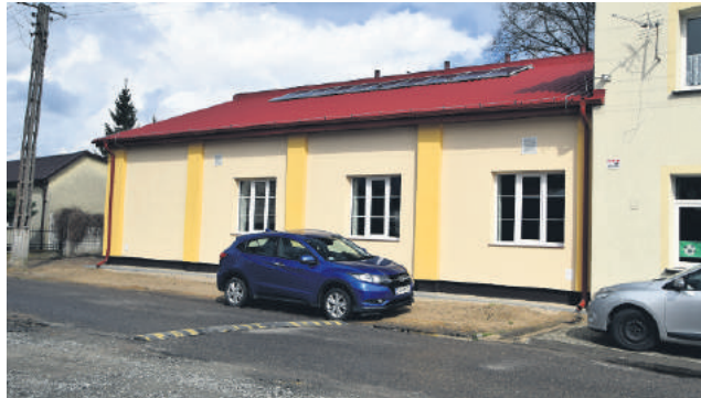
Elewacja świetlicy po remoncie
