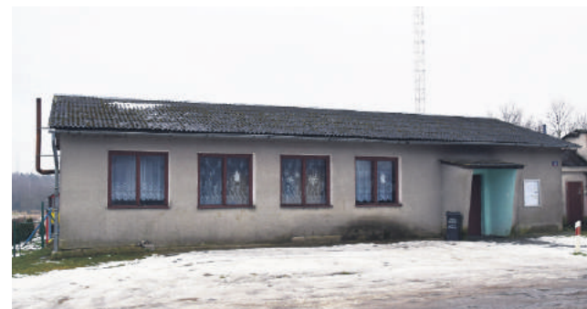
Świetlica przed remontem
