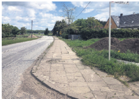
Fragment chodnika przebudowany przez ZZDW w Koszalinie
