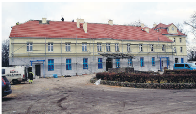
Pałac w Kwasowie w trakcie remontu (grudzień 2020)
