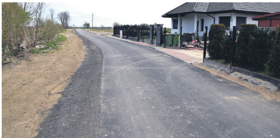
Nowa droga prowadzi w kierunku planowanego do przebudowy boiska
