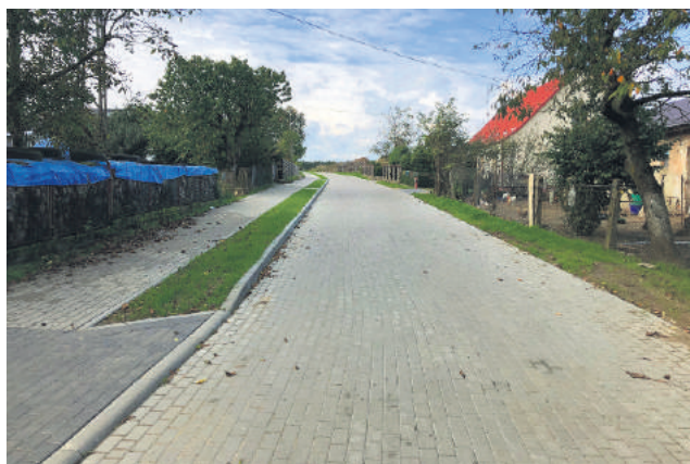
Droga z trylinki zastąpiona została drogą brukową z chodnikiem i zjazdami
