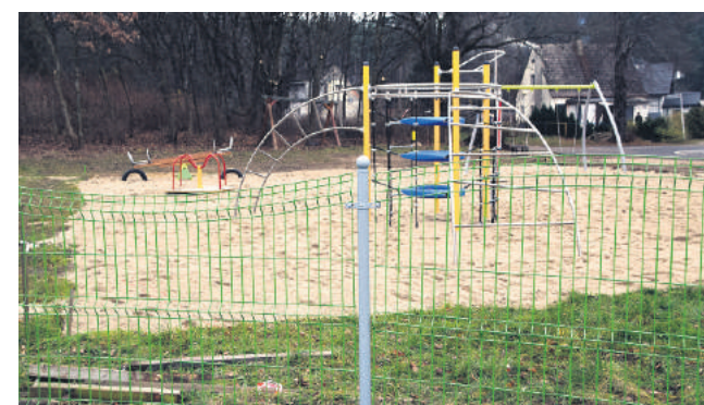
W ramach realizacji I etapu budowy strefy rekreacyjnej w Łętowie postawiono nowe urządzenia i ogrodzono teren
