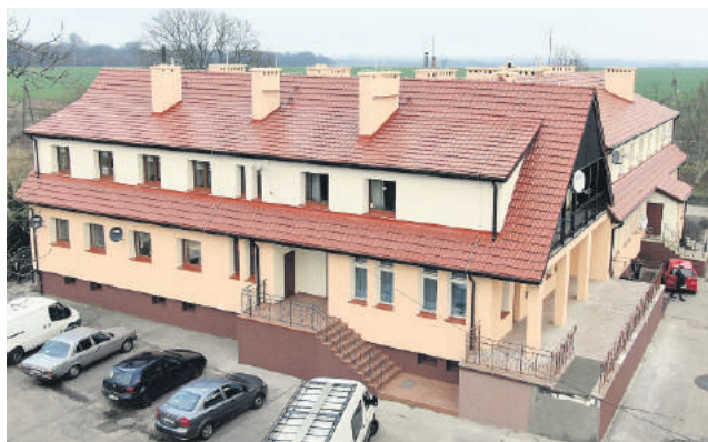
Budynek wielolokalowy pod nr 40 w Rzyszczewie przeszedł kompleksowy remont i termomodernizację
