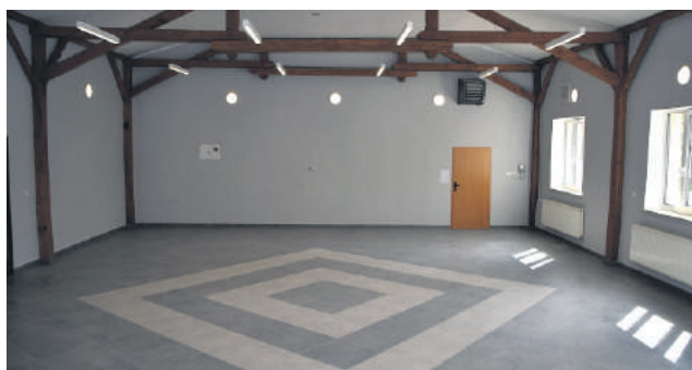
Sala po remoncie
