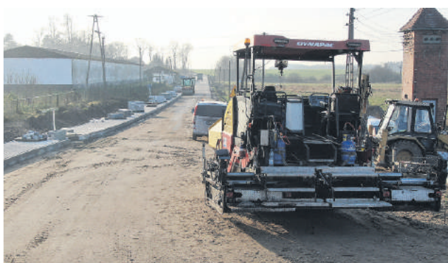
Wykonawcą prac budowlanych jest Przedsiębiorstwo Robót Inżynierskich i Budowlanych „INFRABUD” Spółka z o.o. z Koszalina
