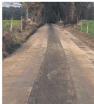
Wykonano podbudowę i ułożono drogę z płyt
