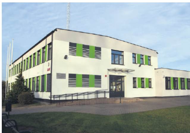
... i po kompleksowym remoncie i termomodernizacji
