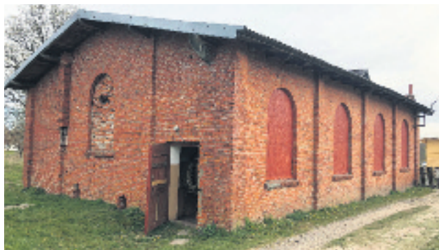
Zabytkowy obiekt z czerwonej cegły przed modernizacją
