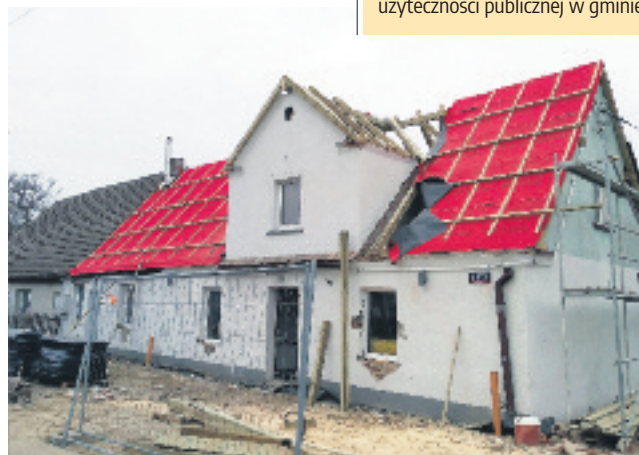
Aktualnie zmieniane jest poszycie dachu
