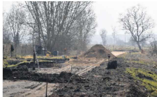
W niektórych miejscach układana jest już podbudowa
