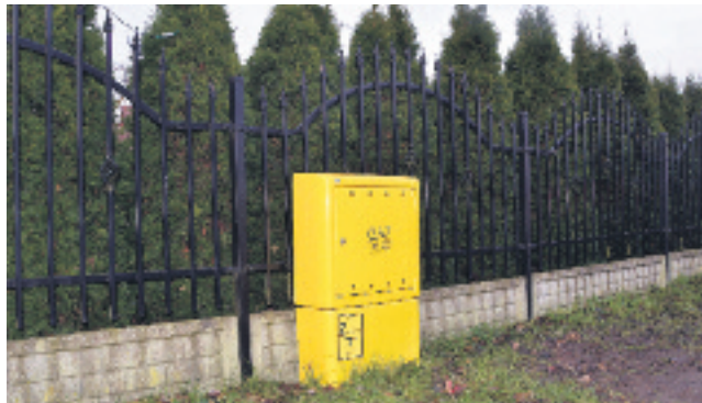
Przyłącza gazu ziemnego powstały już w północnej części Warszawy.
