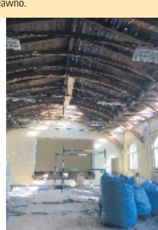
Prace rozbiórkowe rozpoczęto od wnętrza świetlicy
