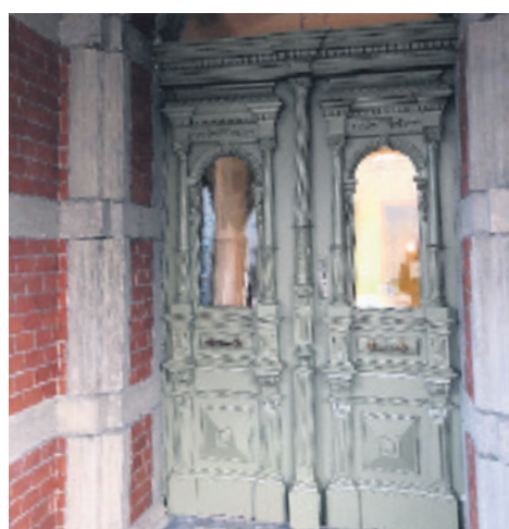
Odrestaurowano oryginalne, drewniane drzwi wejściowe
