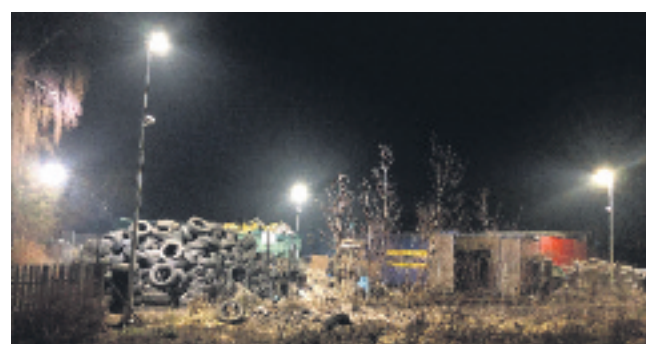
Na terenie PSZOK-u w Warszowie zamontowano oświetlenie, kamery i alarm
