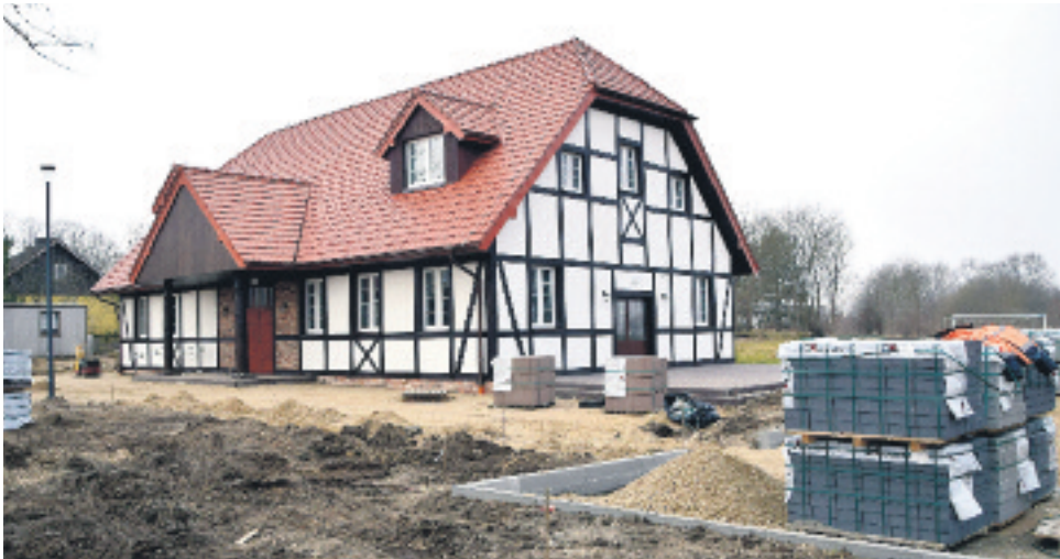
Trwają prace przy budowie parkingu i chodników
