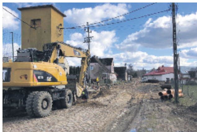
Prace w Warszkwie rozpoczęto od układania kanalizacji deszczowej
