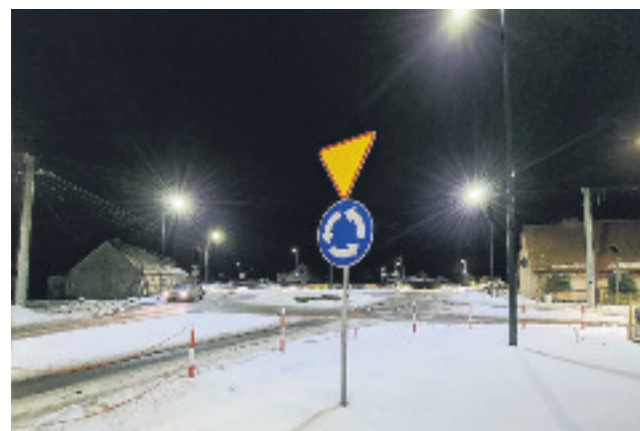
Oświetlenie poprawia bezpieczeństwo mieszkańców i kierujących
