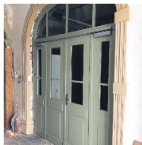
Stylizowane, ale nowoczesne, spełniające wszelkie wymogi drzwi oddzielają poszczególne poziomy od klatki schodowej
