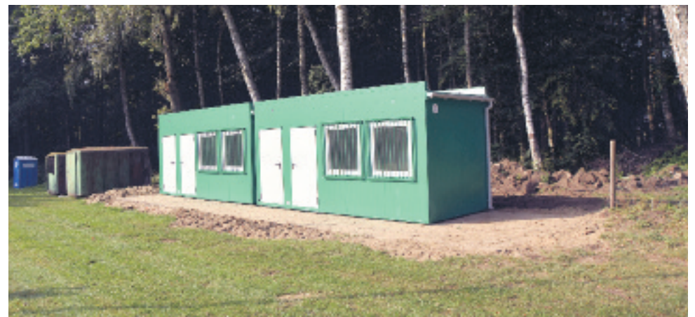
Kontenery socjalne pełniące rolę szatni zamontowano w 2019 roku
