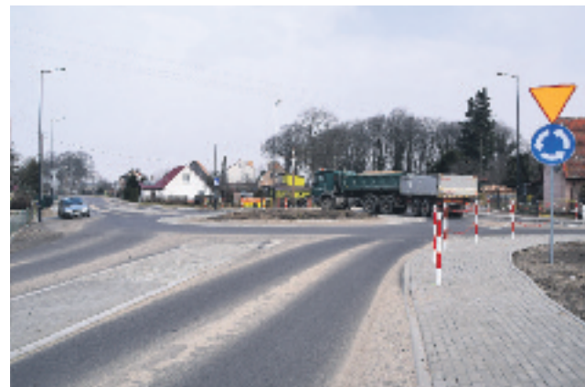
W trakcie inwestycji przebudowano też sieci biegnące pod jezdnią
