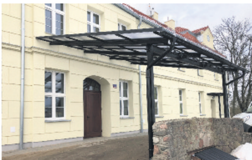
Odrestaurowano oryginalną konstrukcję zadaszenia przed wejściem głównym do budynku
