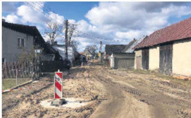
Prace prowadzone są na całym przebudowywanym odcinku
