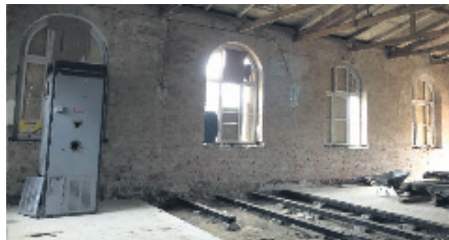
Pierwsze prace rozbiórkowe rozpoczęto w lutym br.
