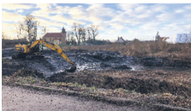
Rozpoczęto prace przy oczyszczaniu zbiorników wodnych
