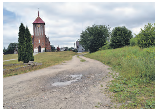
Przebudowana zostanie m.in. droga przy kościele w Tychowie
