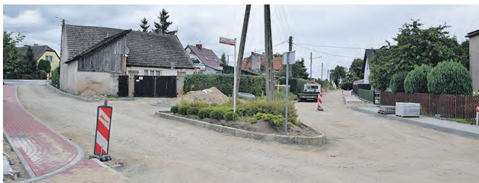
Przygotowano podłoże pod ułożenie nawierzchni asfaltowej
