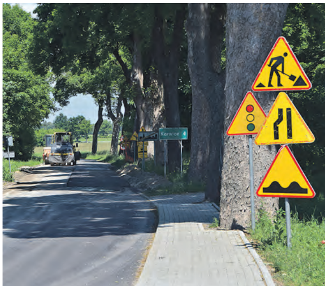
Droga w Smardzewie w trakcie budowy
