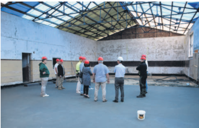
W trakcie przebudowy świetlicy w Warszowie
