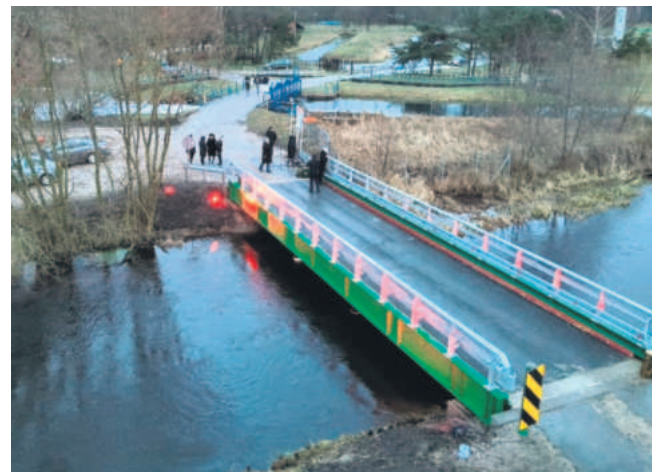
Odrestaurowana konstrukcja mostowa zainstalowana została w Pomiłowie
