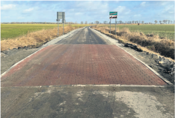
Drogę przebudowano od granicy Noskowa
