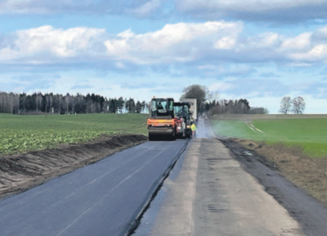
Przebudowa drogi powiatowej na odcinku Smardzewo-Ostrowiec
