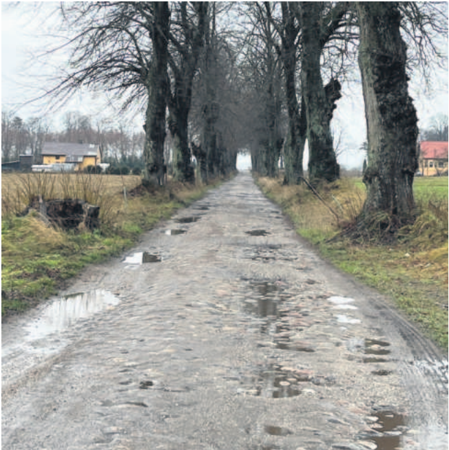
Przebudowana zostanie droga brukowa w Brześciu
