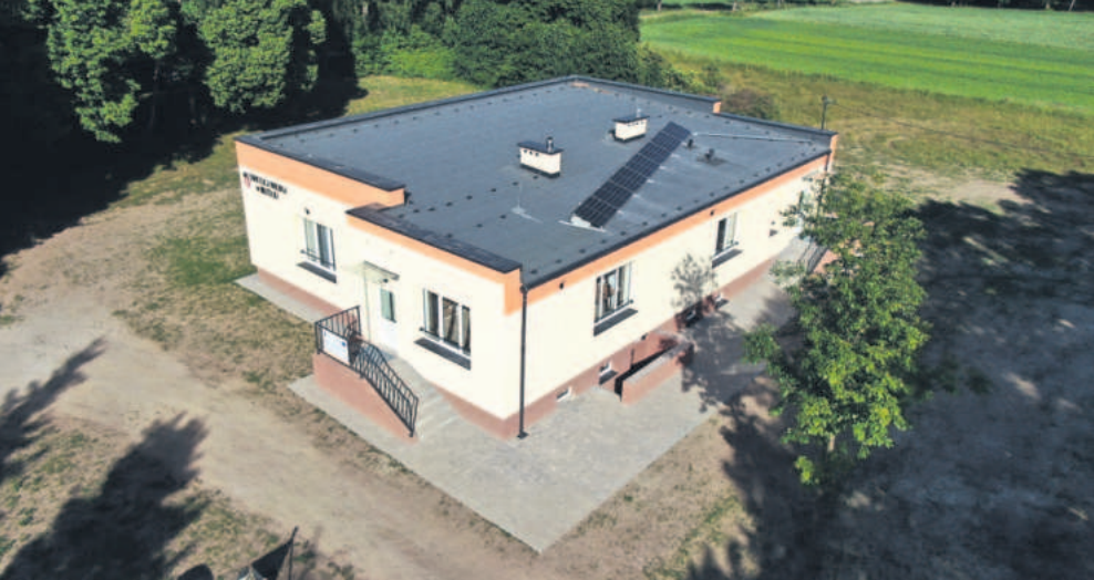
Panele fotowoltaiczne na świetlicy w Brześciu
