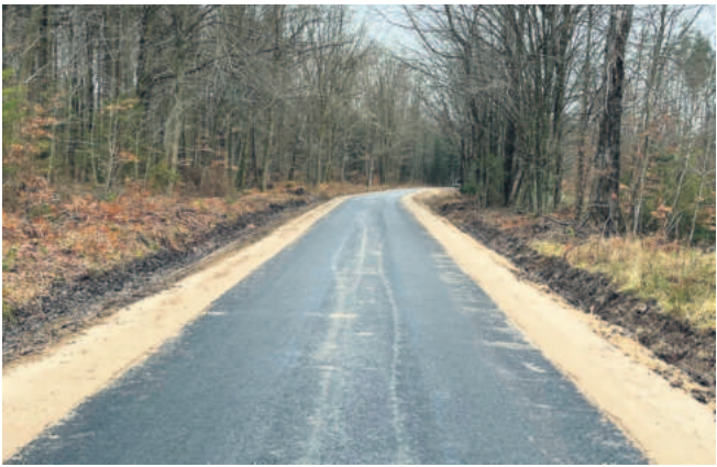
Wybudowano 70% (2,15 km) drogi łączącej Radosław i Stary Kraków. Wybudowana droga gminna stanowić będzie urokliwy odcinek projektowanej trasy rowerowej.
