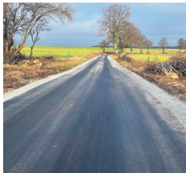
Poszerzono jezdnię i ułożono asfalt
