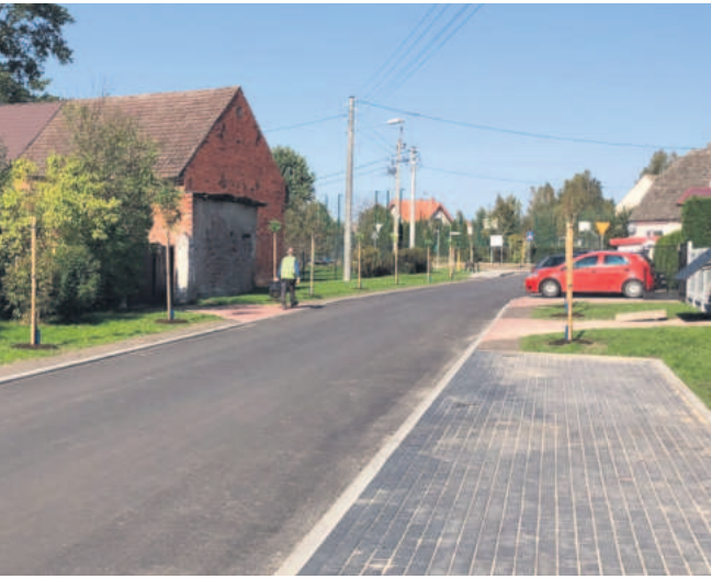
III etap przebudowy dróg w Warszowie
