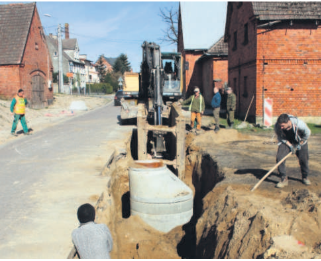
Budowa sieci wodno-kanalizacyjnej w Sławsku
