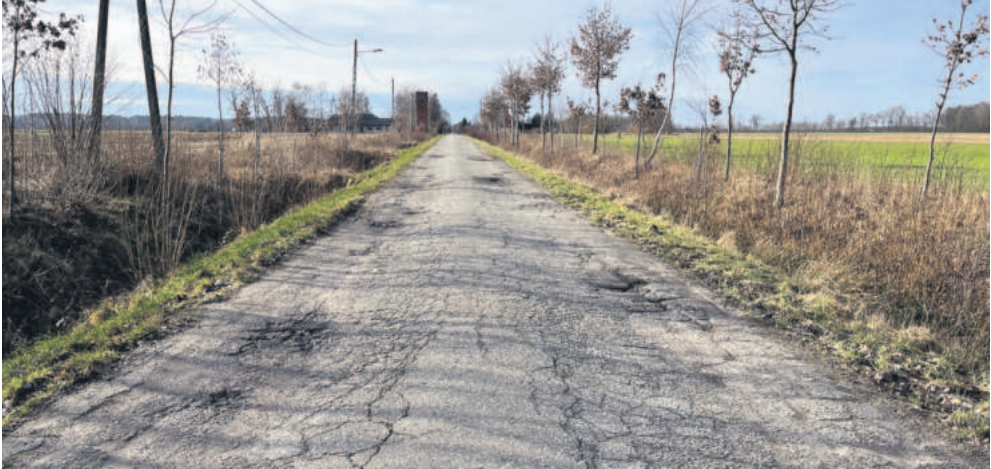
Tokary – droga do przebudowy
