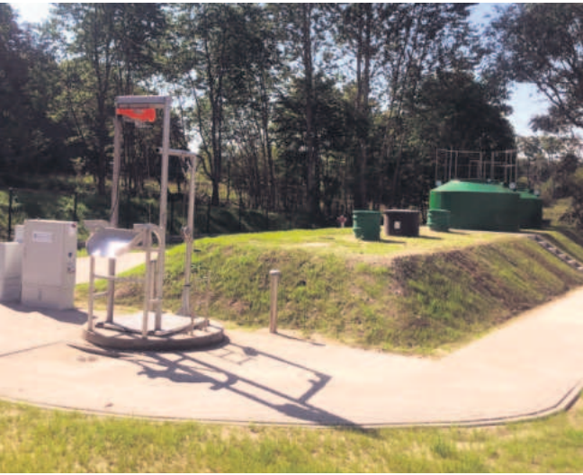
Oczyszczalnia ścieków w Starym Krakowie
