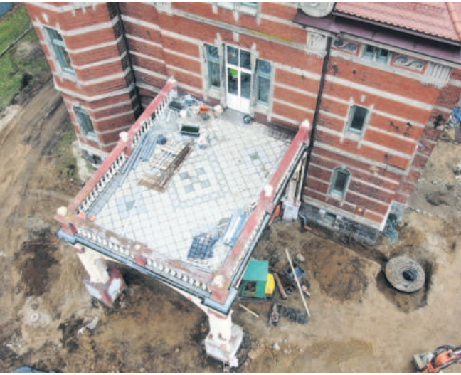
Remont siedziby Urzędu Gminy
