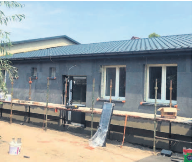
Remont i termomodernizacja świetlicy wiejskiej w Warszowie
