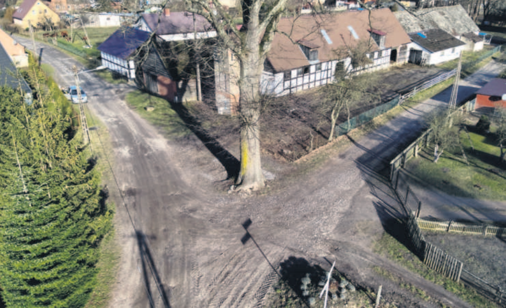
Przebudowany zostanie odcinek drogi powiatowej (po lewej) i gminnej (po prawej) w Łętowie
