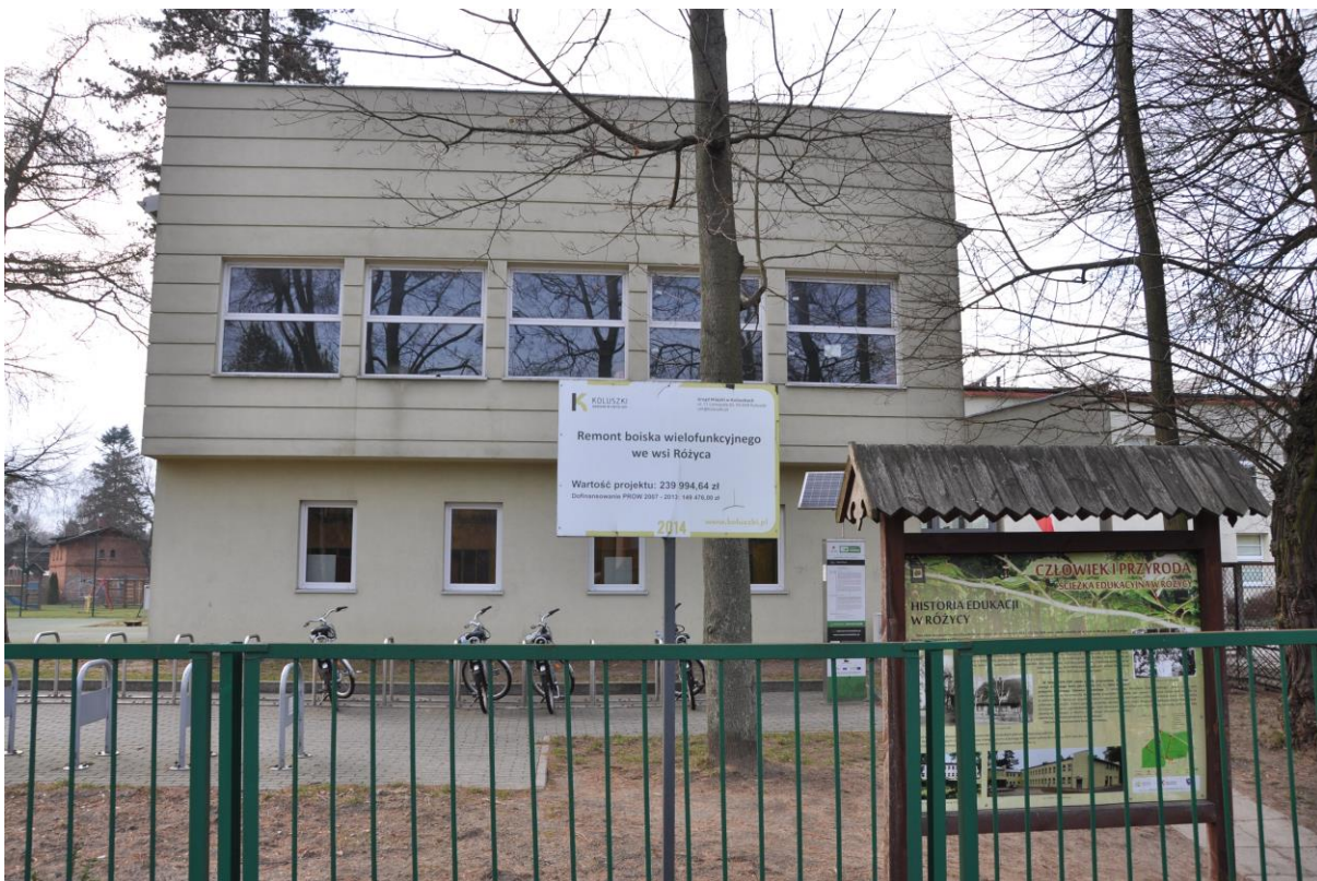
Fot. 8 Szkoła podstawowa im. J. Tuwima w Różycy (północna strona inwestycji)
