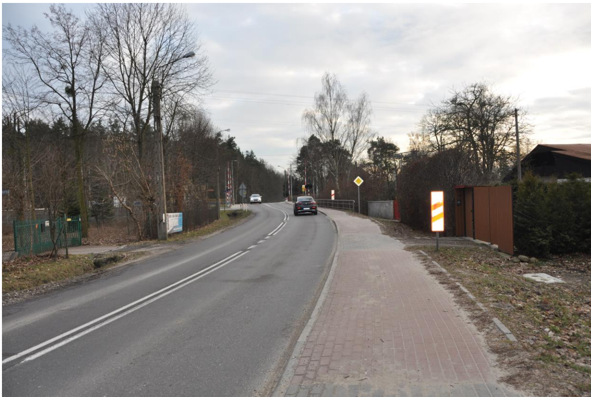
Fot. 1 Ul. Piotrkowska (widok w stronę istniejącego przejazdu po stronie północnej inwestycji)
