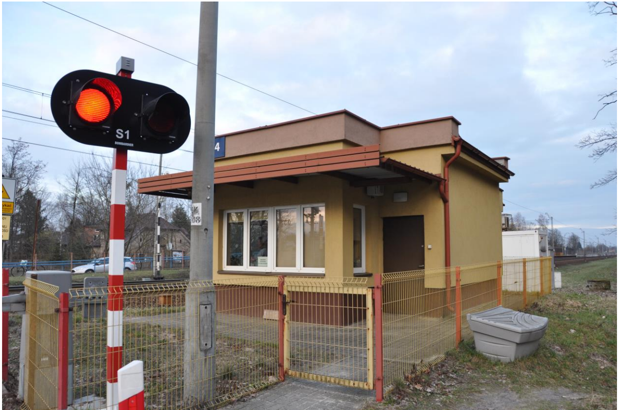
Fot. 9 Budynek obsługi przejazdu
