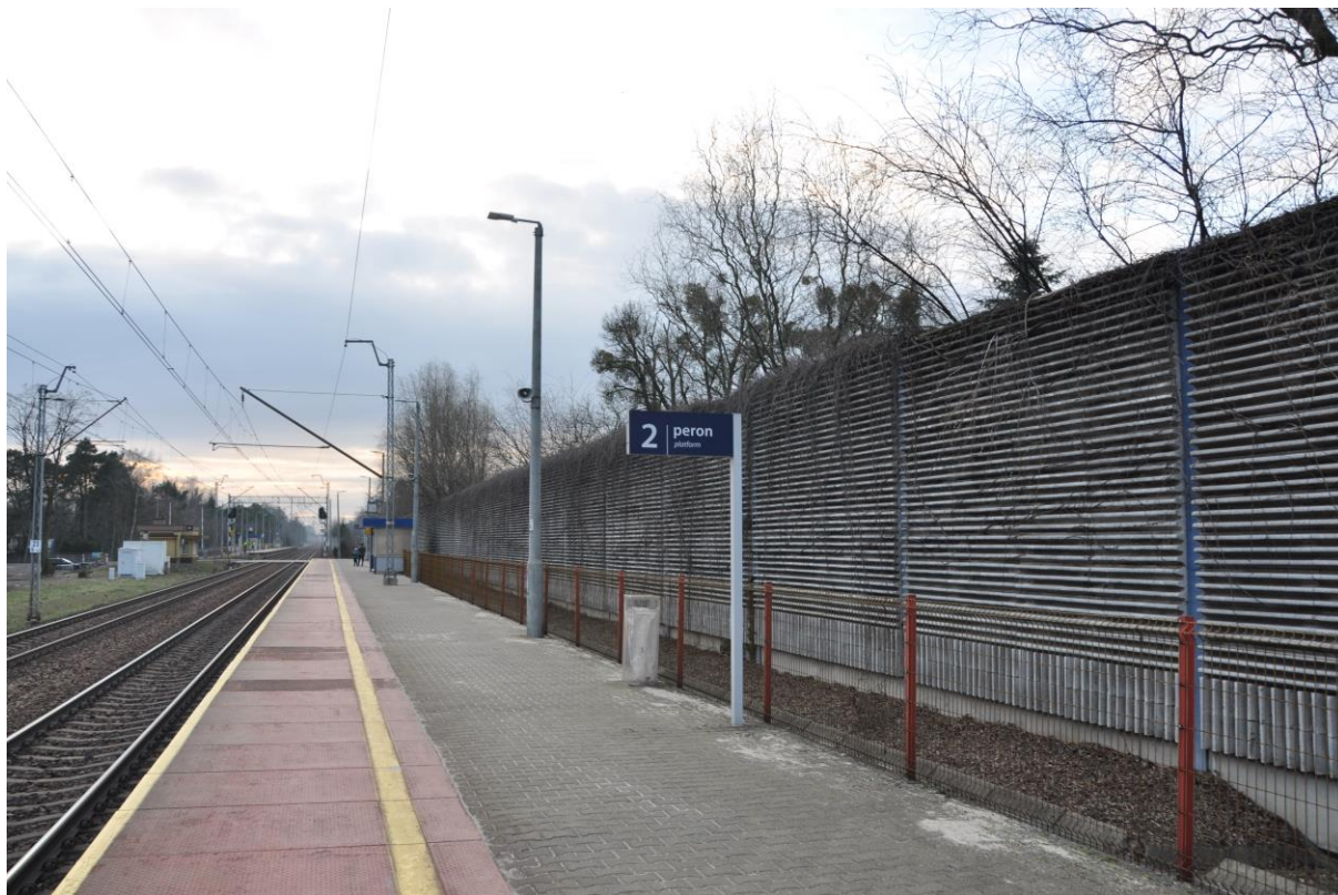
Fot. 3 Widok na peron 2, stacja „Żakowice”
