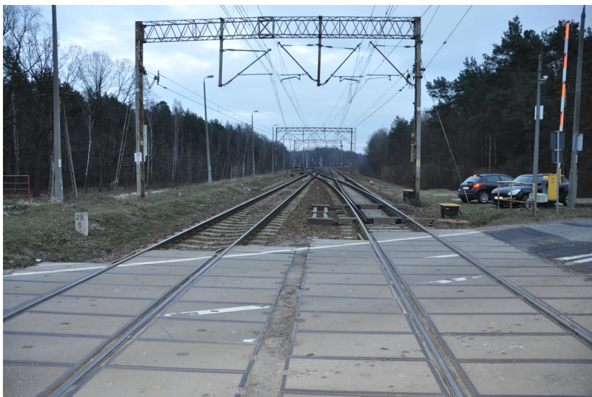
Fot. 4 Przejazd kolejowy kat. A numer 025 028 490
