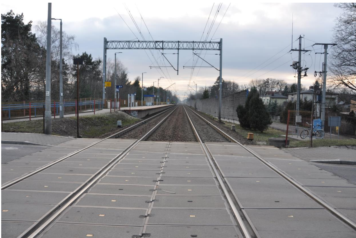
Fot. 2 Istniejący przejazd kat. A numer 017 023 506
