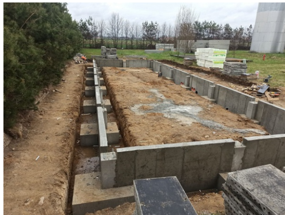
Budowa SUW w Bielsku
