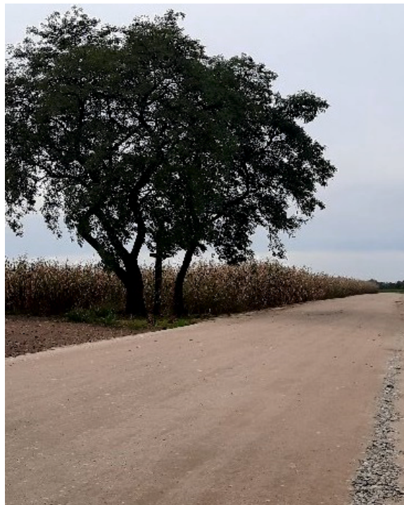
Przebudowana droga w Ultowie
