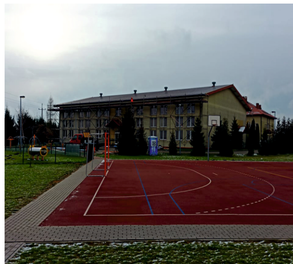
Nowy dach z blachy trapezowej na budynku hali sportowej
