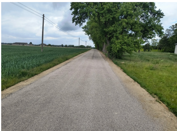
Wyremontowana droga Rudowo – Ułtowo
