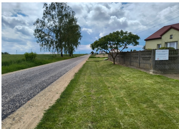
Zmodernizowana droga Gilino - Kuchary
