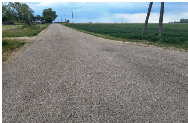
Wyremontowana droga Rudowo – Ułtowo
