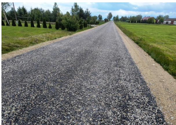
Zmodernizowana droga Gilino - Kuchary
