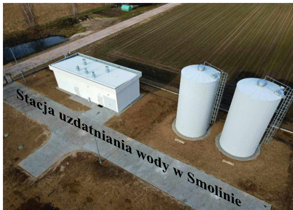
Odbiór stacji uzdatniania wody w Smolinie.
