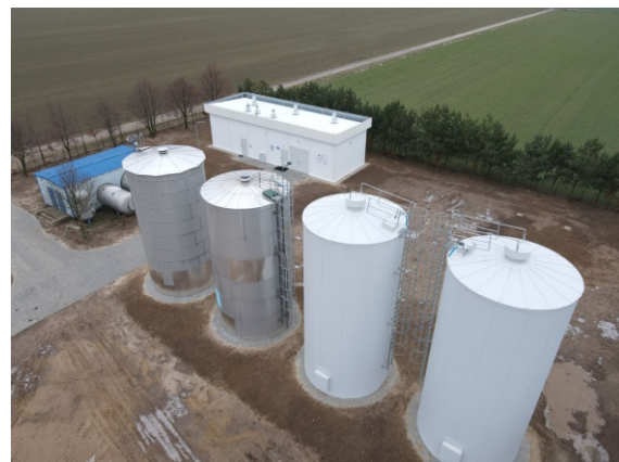
Stacja Uzdatniania Wody w Bielsku
