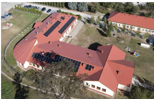
Panele Fotowoltaiczne na budynku Przedszkola w Bielsku
