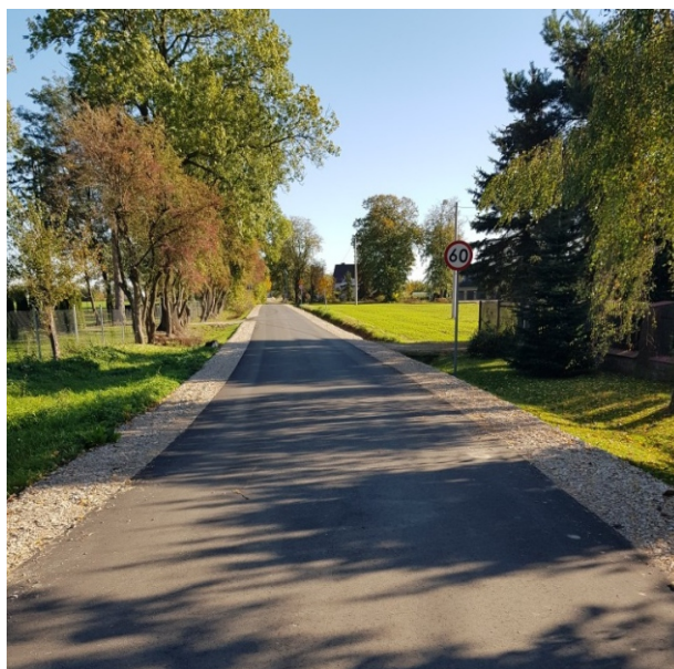
Przebudowana droga w Tchorzu
