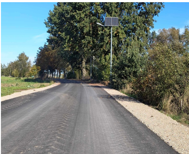
Przebudowana droga w Giżynie
