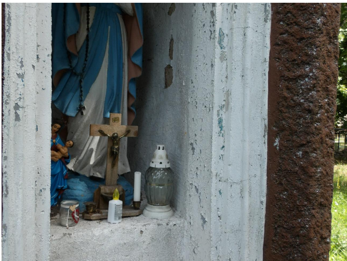
Fot. 18. Malatura niszy uszkodzona, farba łuszczy się i odpada.
