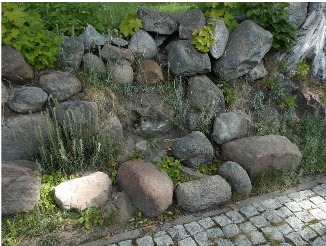
Fot. 3. Brak materiału wiążącego elementy kamienne przyspiesza erozję gleby a w konsekwencji rozluźnienie muru.
