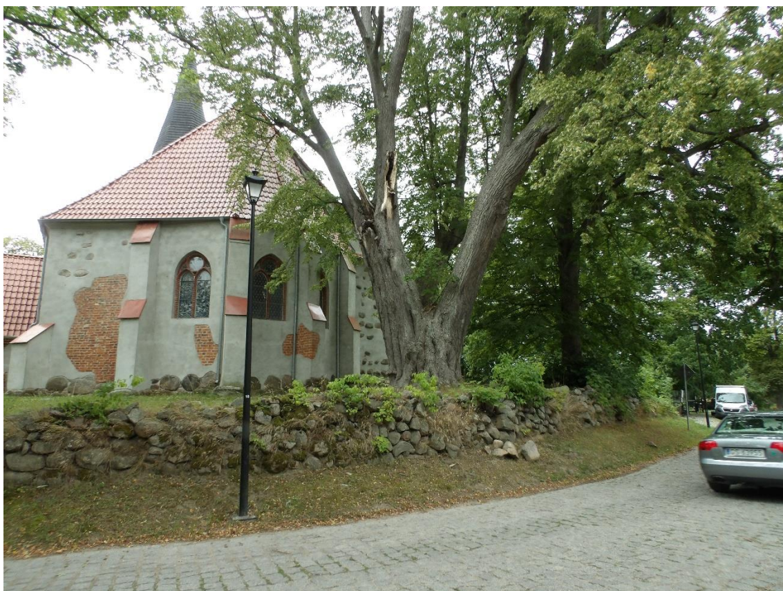
Fot. 8. Widok na ogrodzenie od strony południowo-wschodniej. Elementy kamienne rozsypują się. Ogrodzenie grozi zawaleniem.
