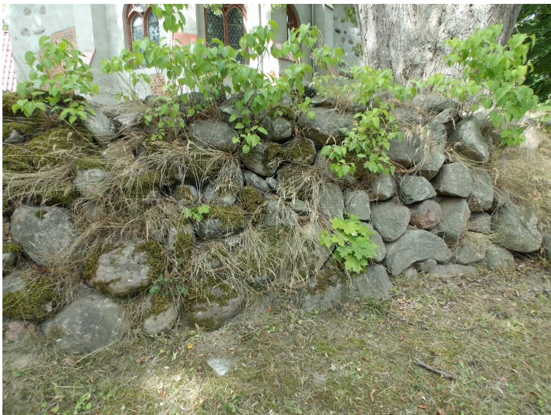
Fot. 5. Ogrodzenie od strony południowo-wschodniej. W ogrodzeniu liczne samosiewy lilaka oraz klona pospolitego. Kamienie porośnięte mchem.
