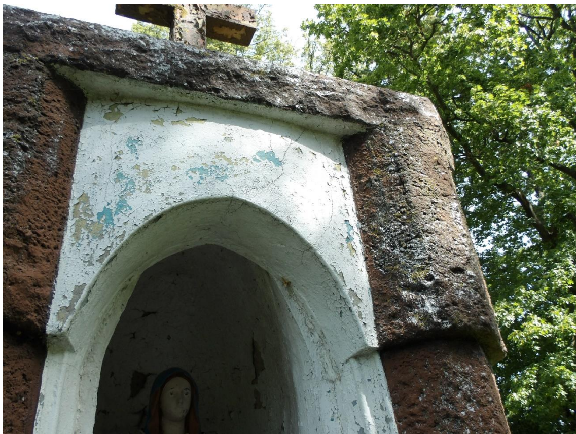
Fot. 17. Wyprawy tynkarskie uszkodzone. Widoczne liczne rysy i pęknięcia. Widoczne porażenie biomasą.
