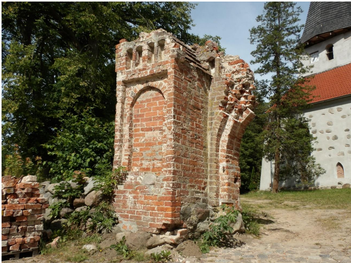
Fot. 9. Zachowana część bramy wjazdowej. Widoczne porażenie biologiczne mchami, glonami i porostami.
