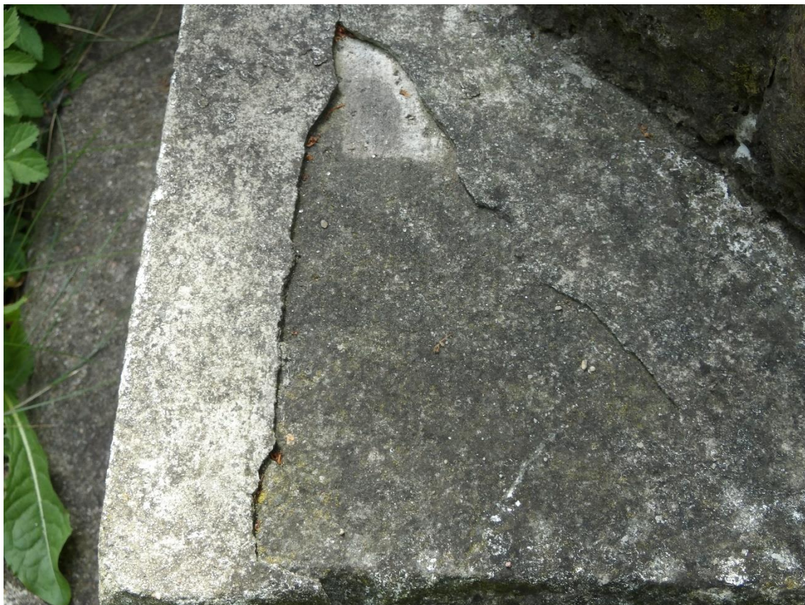
Fot. 24. Postument zasmarowany zaprawką cementową. Na powierzchni silne porażenie biologiczne.
