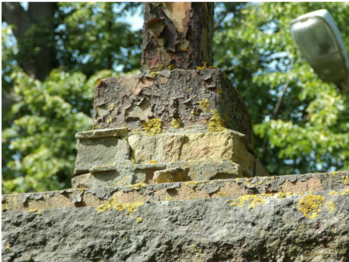
Fot. 21. Silnie uszkodzona podstawa krzyża na zwieńczeniu kapliczki.
