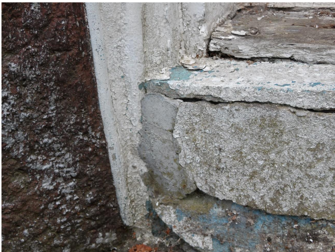
Fot. 23. Nieestetyczne, wtórne uzupełnienie zaprawą cementową.
