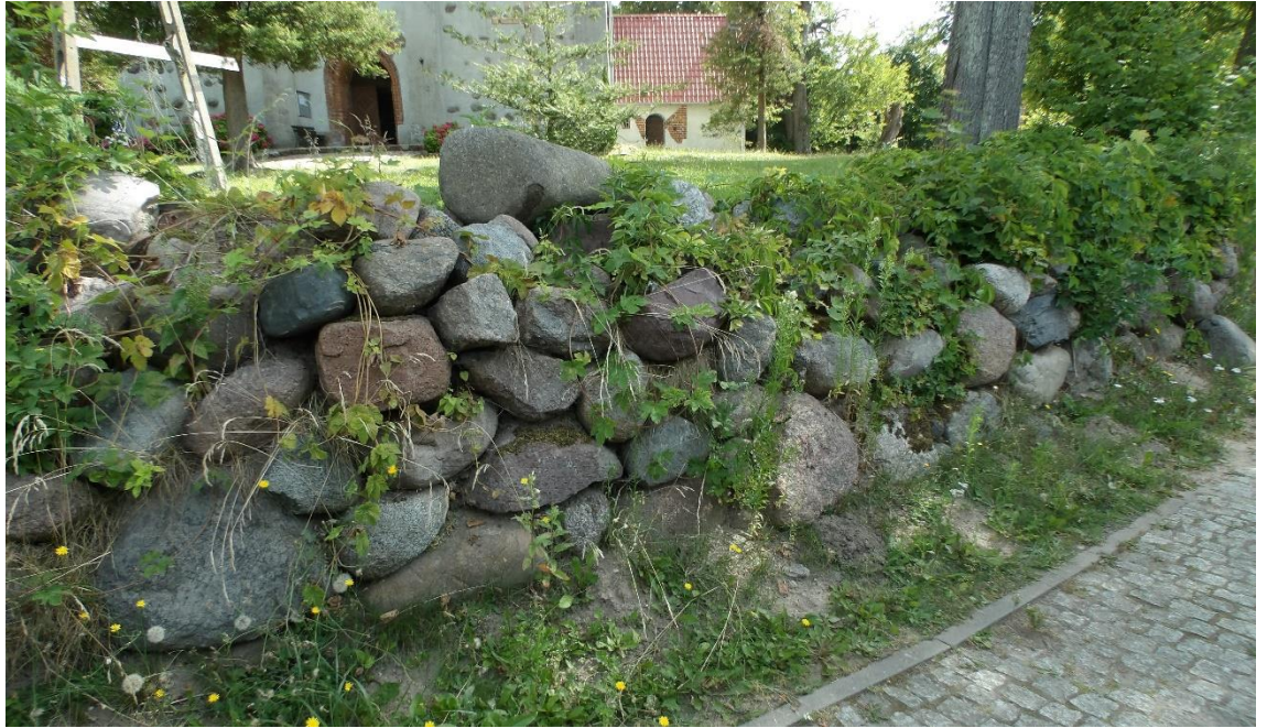
Fot. 1. Ogrodzenie kamienne od strony wschodniej. Elementy kamienne poprzeraśane roślinnością.
