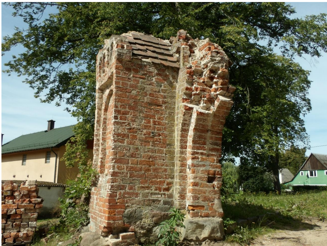
Fot. 10. Zachowana część bramy wjazdowej. Brama na fundamencie kamiennym.
