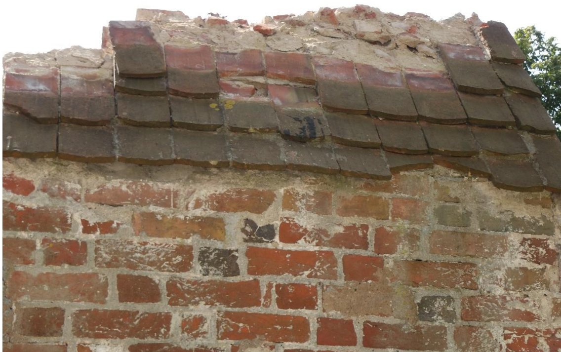
Fot. 13. Zwieńczenie bramy wykończone dachówką ceramiczną. Dachówka uszkodzona.
