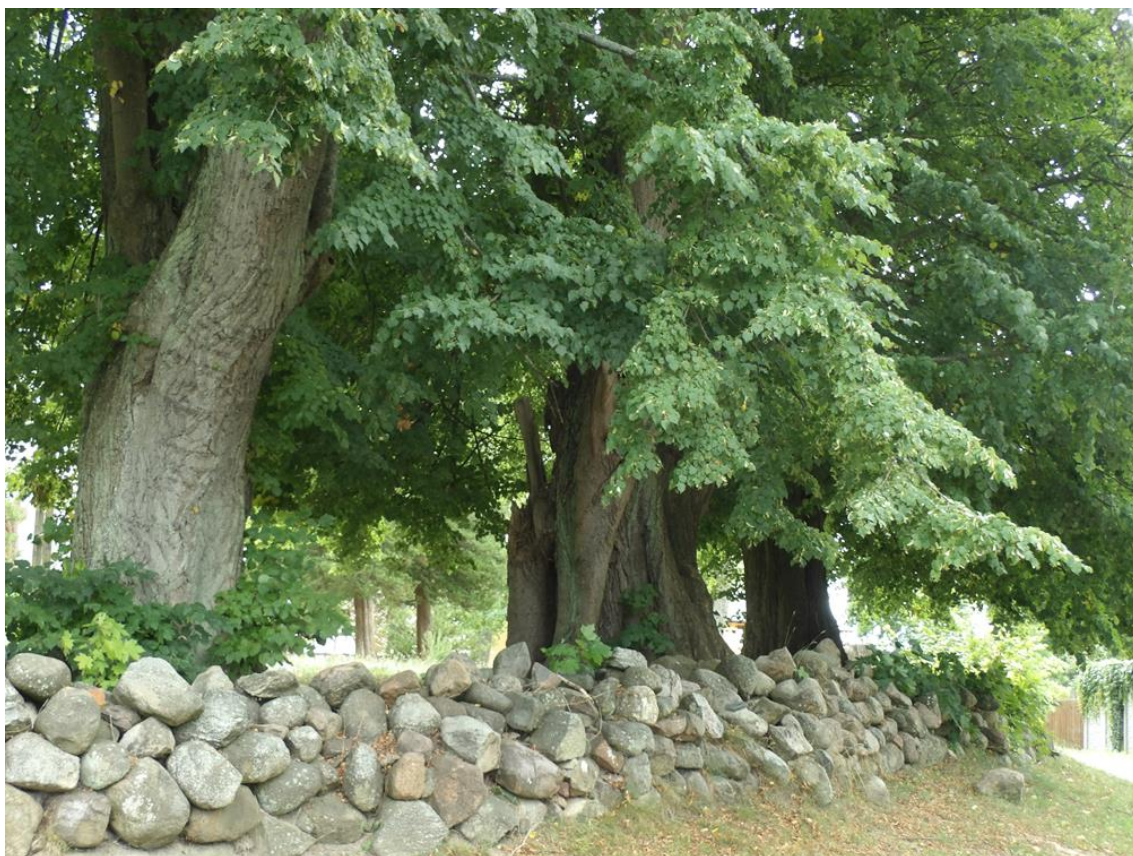
Fot. 7. Widok na ogrodzenie od strony północnej. Ogrodzenie wygląda jak rumowisko. Elementy kamienne zaczynają się rozsypywać.
