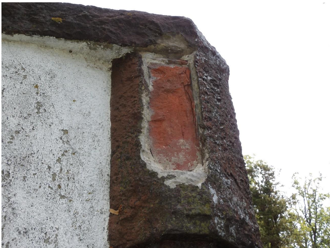
Fot. 19. Uszkodzenia odsłaniające ceglany trzon pomnika.
