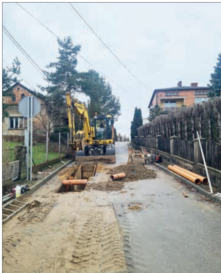
■ Budowa kanalizacji na ul. Nowej w Syryni
