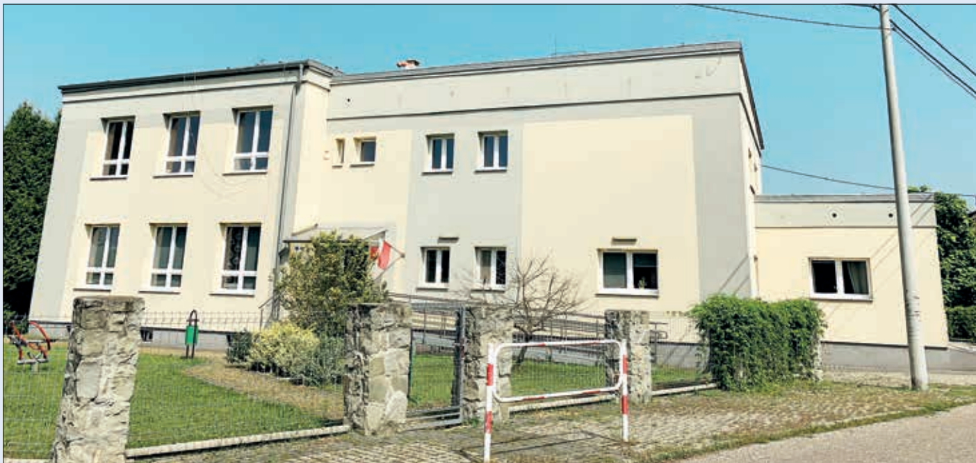
■ W tym budynku w Bukowie na piętrze będzie żłobek
