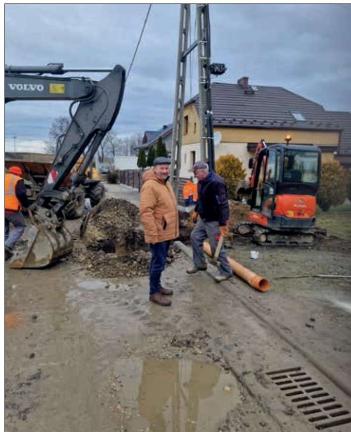
■ Na Jesionowej praca wre... Kanalizowanie „Paprotnika”
