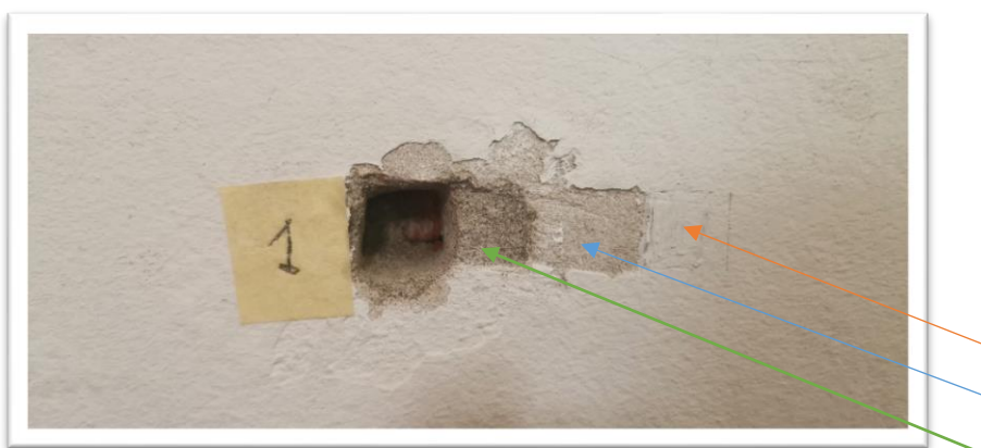
Fot. nr III. Wektorami oznaczono odkryte warstwy technologiczne. Kolorem czerwonym oznaczono zewnętrzną warstwę białej farby (prawdopodobnie emulsyjnej) z silnymi przybrudzeniami. Kolorem niebieskim oznaczono warstwę wtórnego tynku; kolorem zielonym oznaczono warstwę oryginalnego tynku, na którym nie zidentyfikowano śladów polichromii. Warstwa malarska, tynk oraz spoinowanie pomiędzy cegłami wykazuje cechy utraty adhezji i kohezji spowodowanej zawilgoceniem i atakiem mikroorganizmów.
