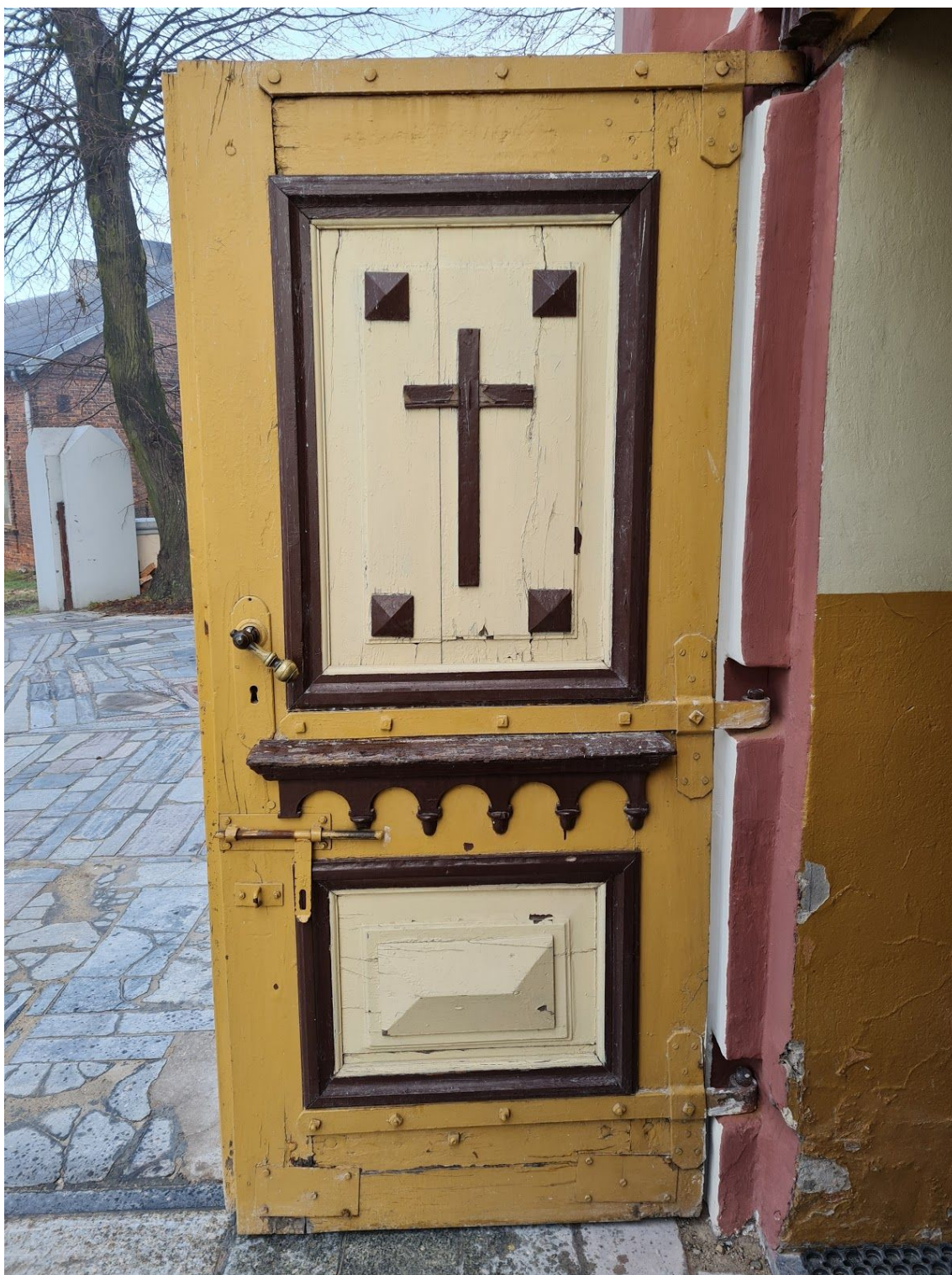
Fot. 3. Drzwi z Kościoła parafialnego p.w. św. Małgorzaty w Zadzimi. Przed konserwacją. Ościeże wewnętrzne. Widoczne łuszczące się przemalowania. Fot. M. Kwiatkowski, 2020 r.
