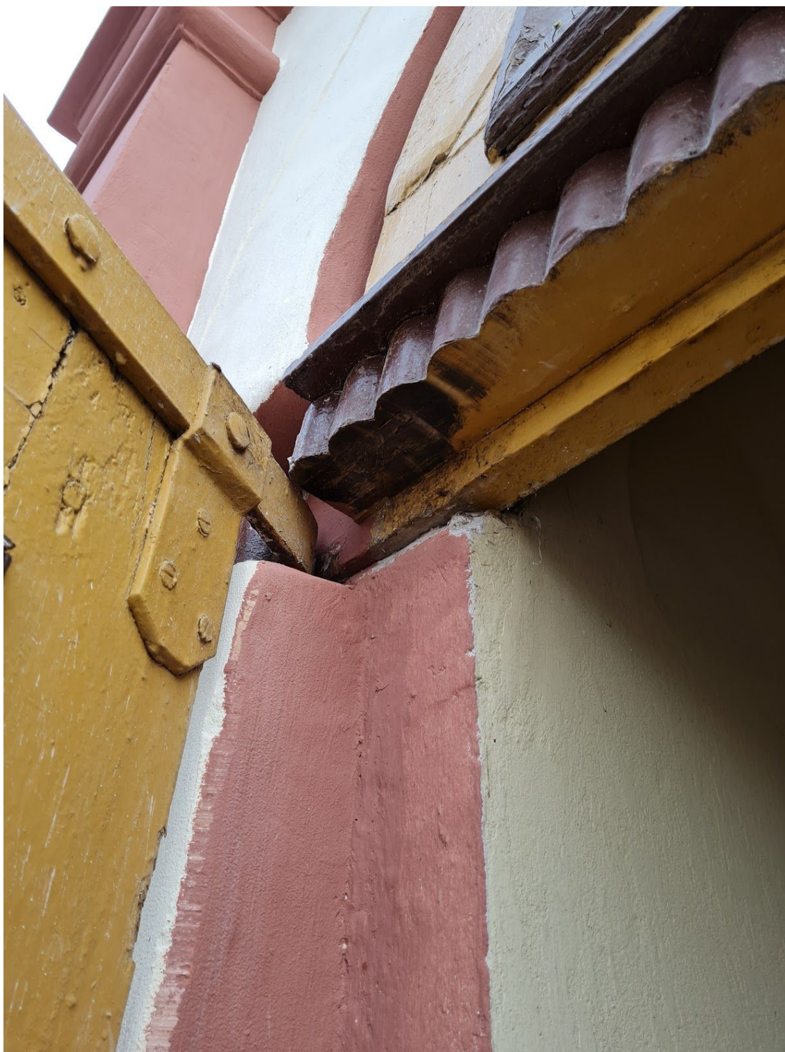
Fot. 10. Drzwi z Kościoła parafialnego p.w. św. Małgorzaty w Zadzimi. Przed konserwacją. Widoczne uszkodzenia wywołane otwieraniem drzwi. Fot. M. Kwiatkowski, 2020 r.
