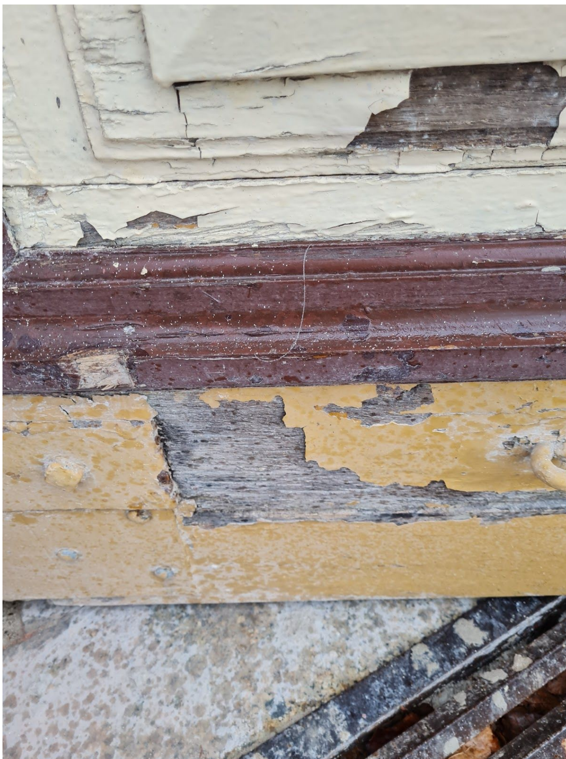
Fot. 11. Drzwi z Kościoła parafialnego p.w. św. Małgorzaty w Zadzimiu. Przed konserwacją. Fragment. Łuszcząca się farba olejna. Fot. M. Kwiatkowski, 2020 r.
