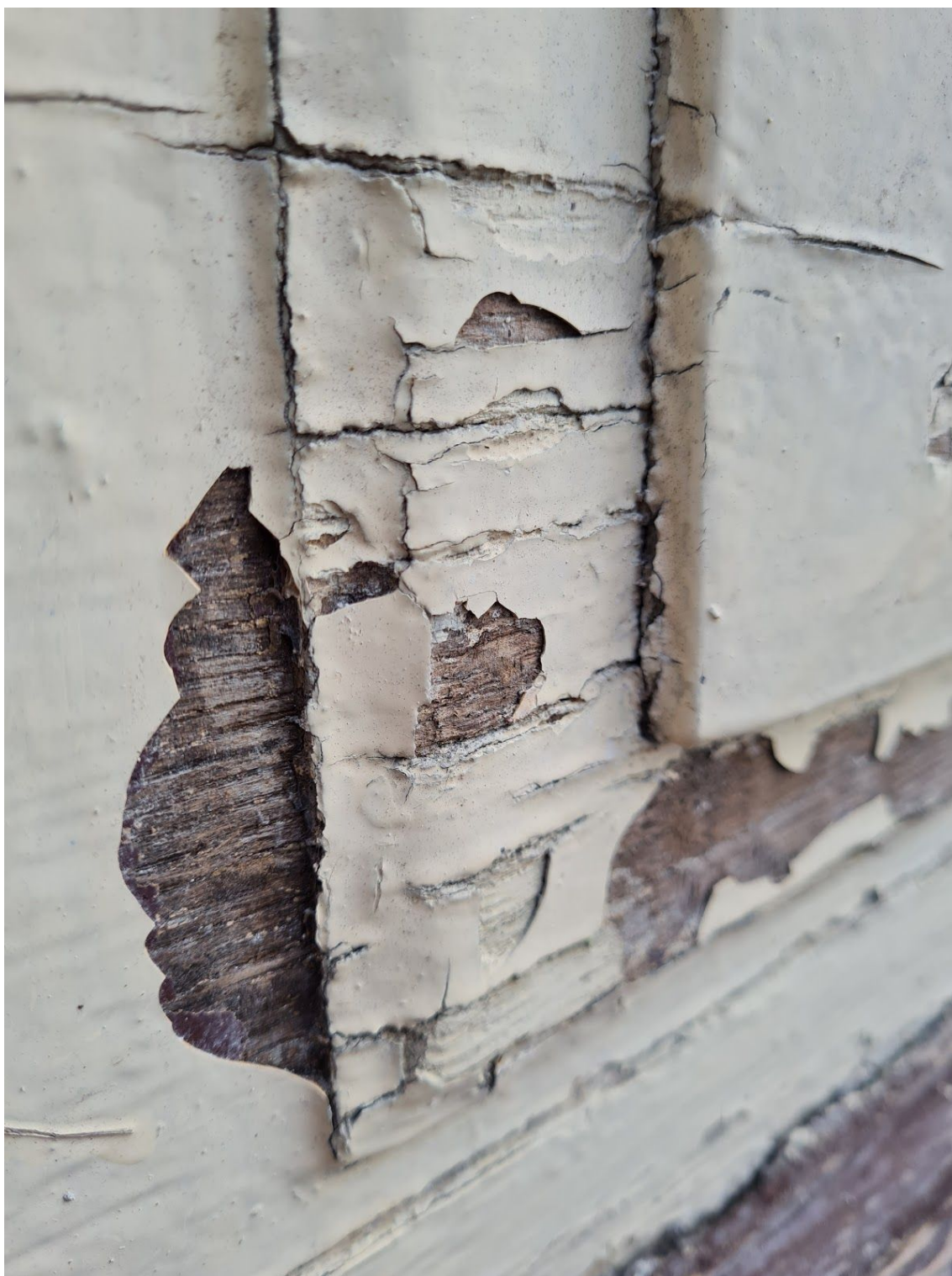
Fot. 7. Drzwi z Kościoła parafialnego p.w. św. Małgorzaty w Zadzimi. Przed konserwacją. Fragment. Łuszcząca się farba. Fot. M. Kwiatkowski, 2020 r.
