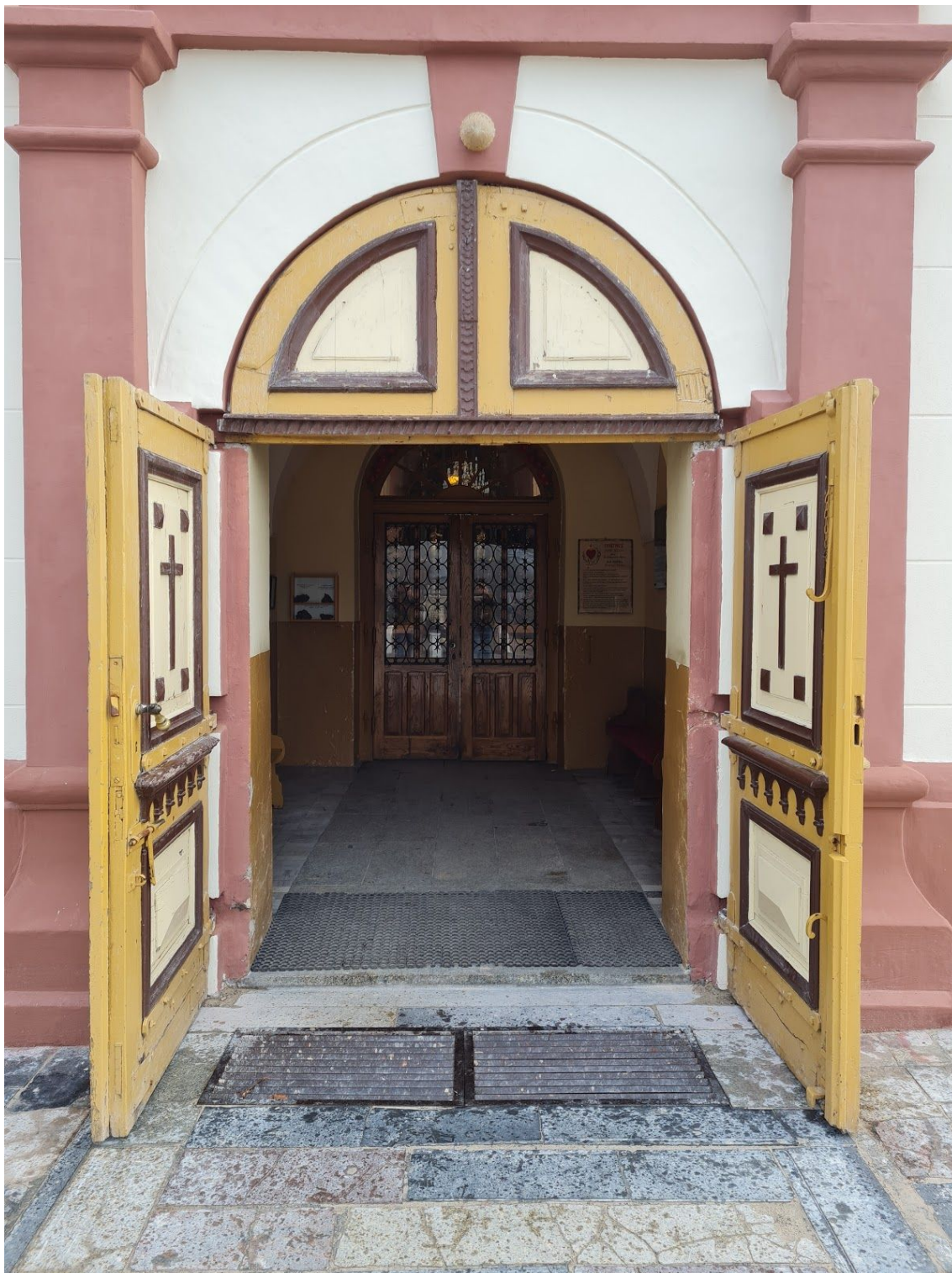
Fot. 1. Drzwi z Kościoła parafialnego p.w. św. Małgorzaty w Zadzimiu. Przed konserwacją. Widoczne uszkodzenia wywołane warunkami atmosferycznymi. Fot. M. Kwiatkowski, 2020 r.
