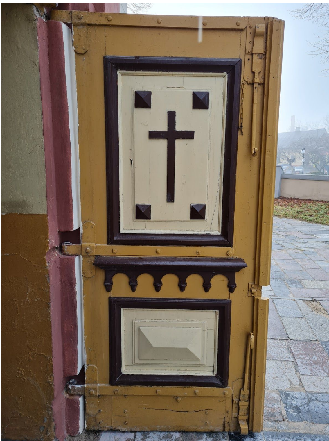
Fot. 4. Drzwi z Kościoła parafialnego p.w. św. Małgorzaty w Zadzimi. Przed konserwacją. Przed konserwacją. Ościeże wewnętrzne. Widoczne łuszczące się przemalowania. Fot. M. Kwiatkowski, 2020 r.
