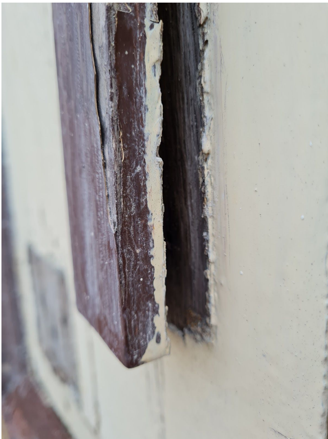
Fot. 9. Drzwi z Kościoła parafialnego p.w. św. Małgorzaty w Zadzimi. Przed konserwacją. Fragment. Odspojenie detalu snycerskiego. Fot. M. Kwiatkowski, 2020 r.
