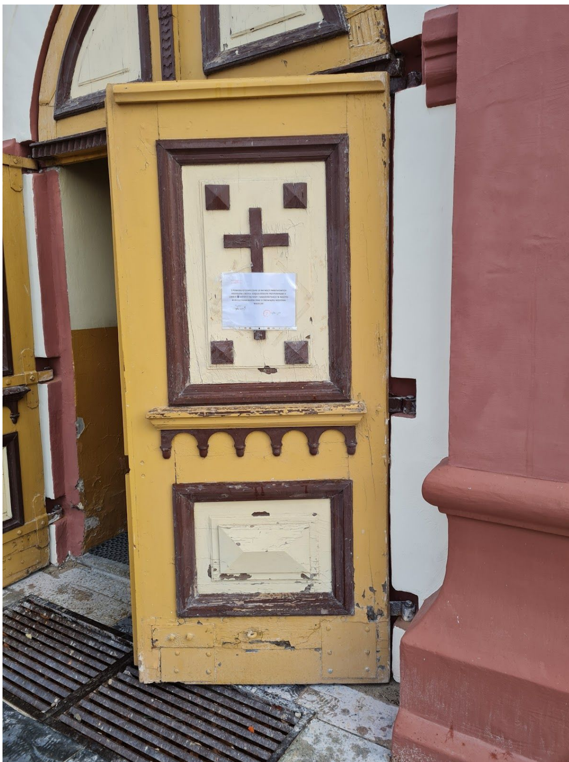
Fot. 2. Drzwi z Kościoła parafialnego p.w. św. Małgorzaty w Zadzimi. Przed konserwacją. Widoczne uszkodzenia wywołane warunkami atmosferycznymi, przemalowania. Fot. M. Kwiatkowski, 2020 r.
