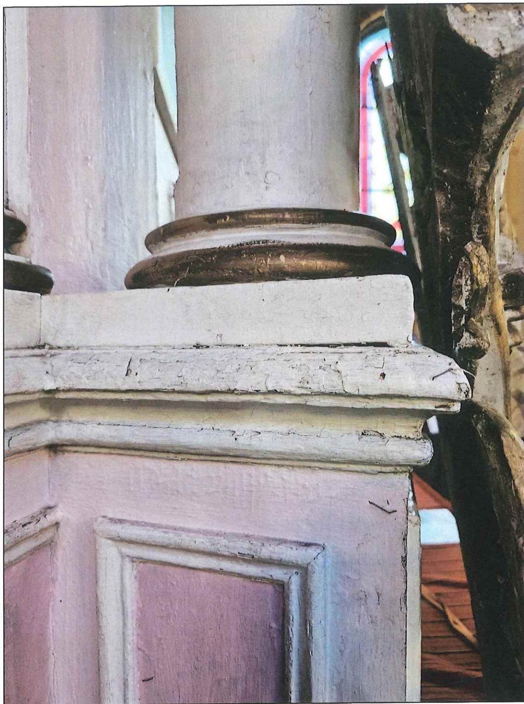
Fot.17. Ołtarz boczny p.w. Św. Anny Samotrzeć w kościele w Małyniu. Fragment predelli: widoczny stan zachowania współczesnej warstwy malarskiej. Ostatnie odnowienie wykonane w sposób niechlujny na zniszczonym podłożu.
