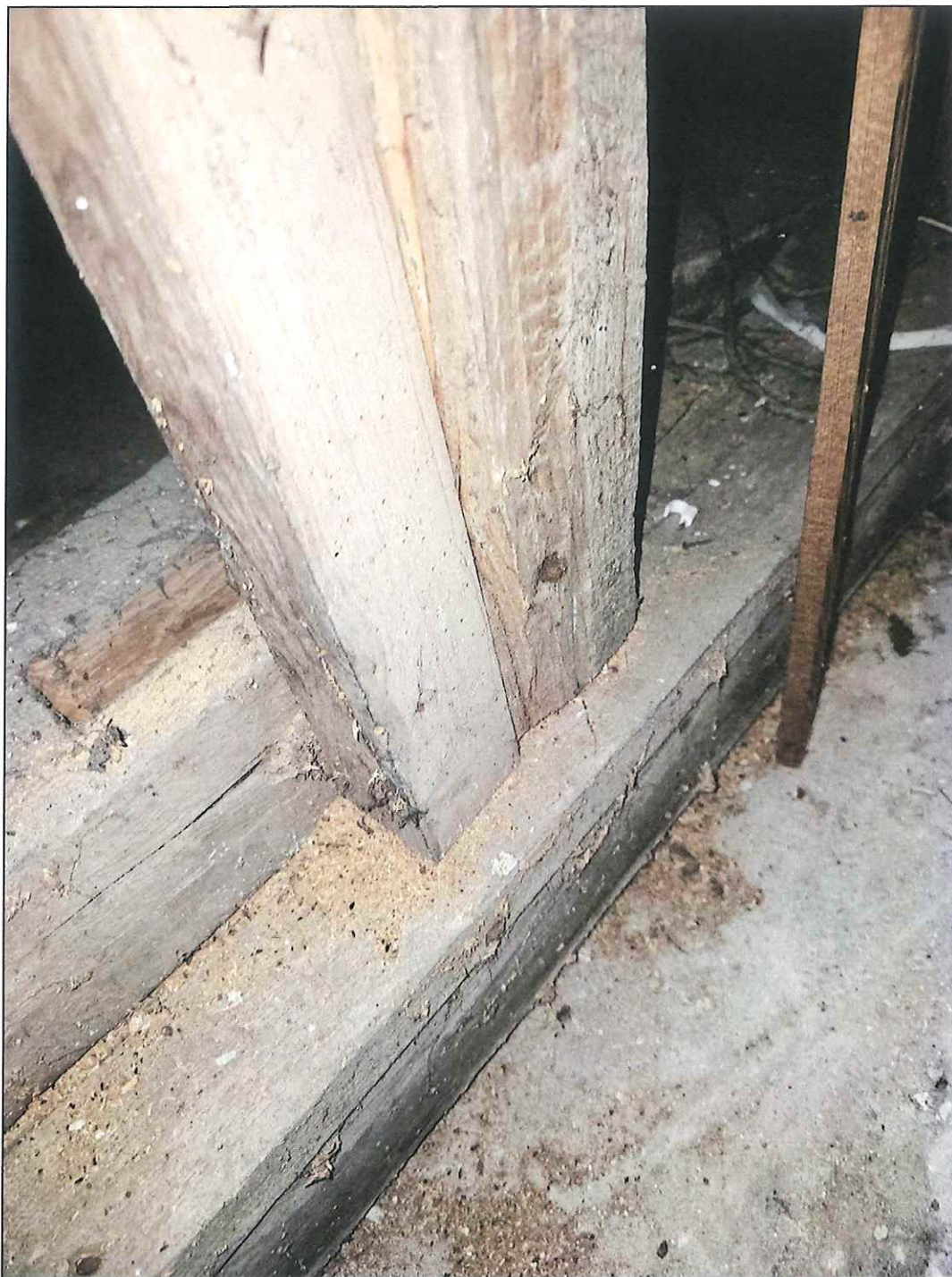
Fot.25. Ołtarz boczny p.w. Św. Anny Samotrzeć w kościele w Małyniu. Odwrocie ołtarza. Widoczne trociny, świadectwo żerowania drewnojadów.
