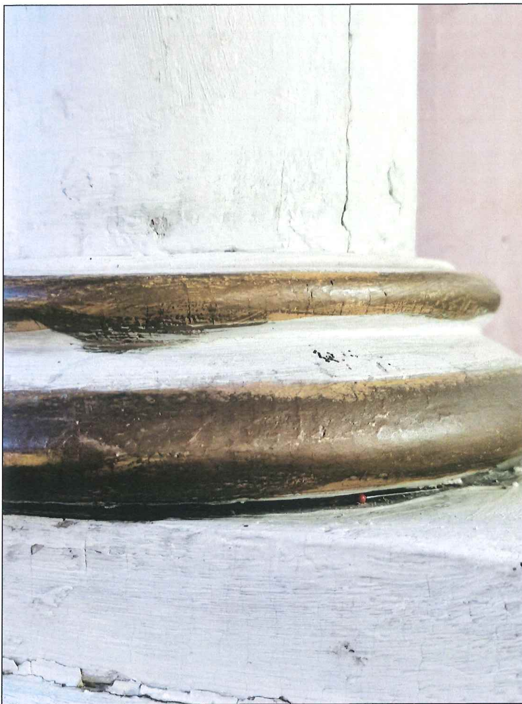
Fot.19. Ołtarz boczny p.w. Św. Anny Samotrzeć w kościele w Małyniu. Fragment bazy kolumn. Złocenia retuszowane farbą w kolorze złota.
