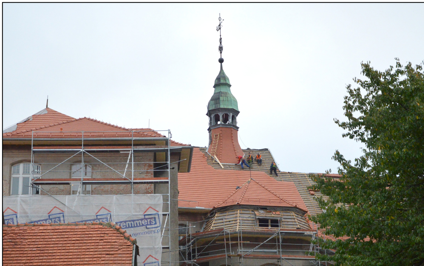
Remont dachu potrwa do przyszłego roku.
