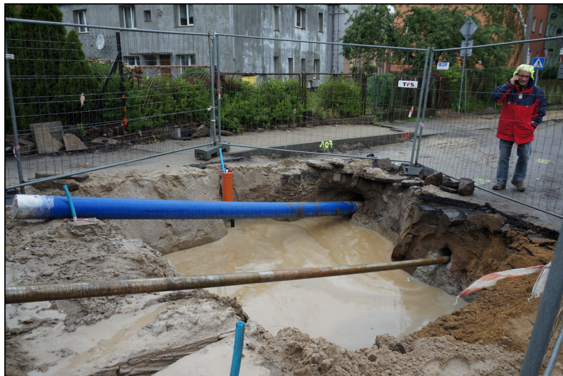
Inspekcja rurociągu przeprowadzana była zdalnie sterowaną kamerą.
