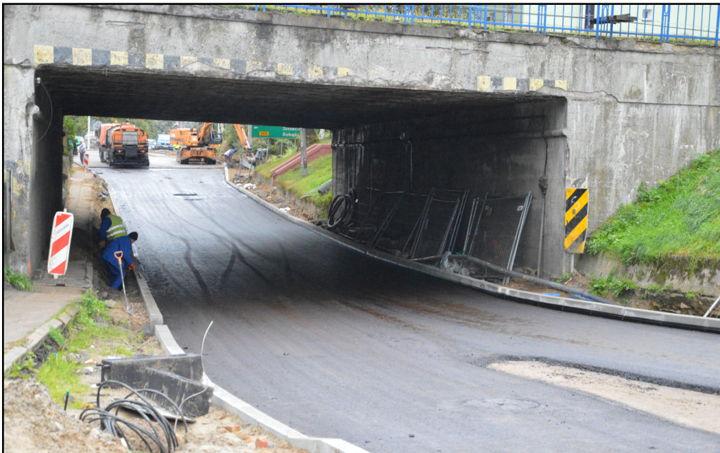
Prace pod wiaduktem coraz bliżej końca.
