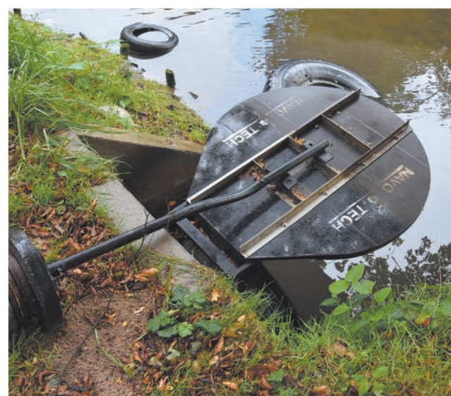
Kłapa zwrotna przy rzece Moszczenicy
