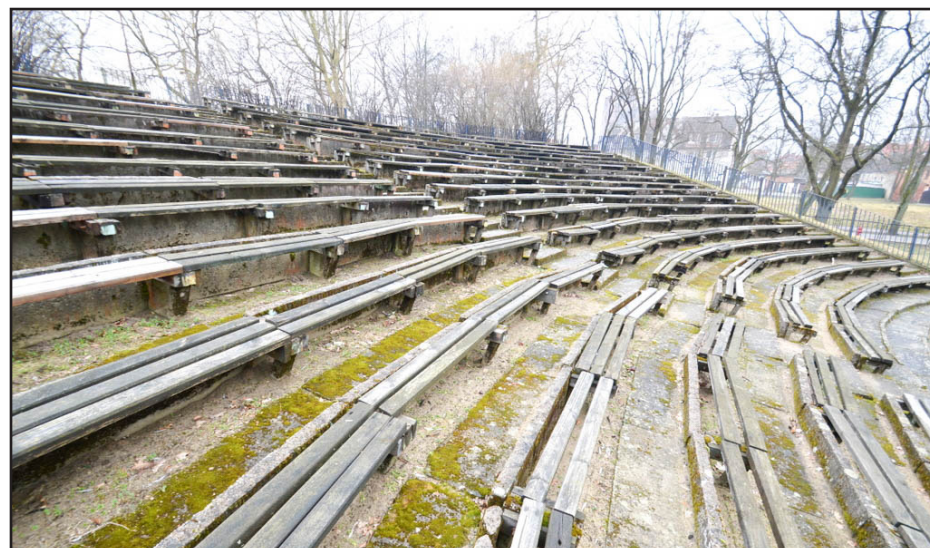
Remont amfiteatru potrwa do 30 lipca 2017 roku.
