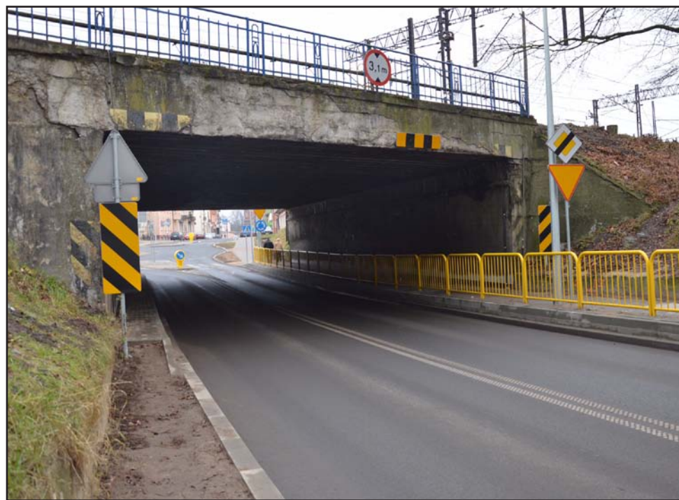
Remont wiaduktu rozpocznie się na początku 2017 r.
