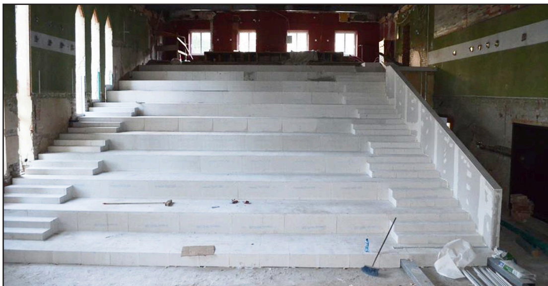
Wyprofilowana została podłoga, a już wkrótce rozpocznie się montaż nowych foteli
