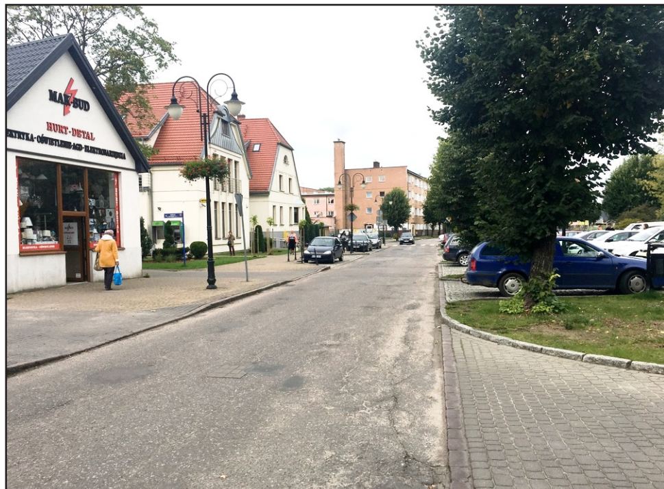
Całkowita długość remontowanego odcinka to 471m.
