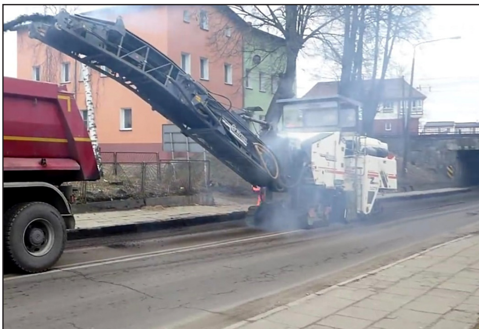
Prace robocze przy zrywaniu asfaltu
