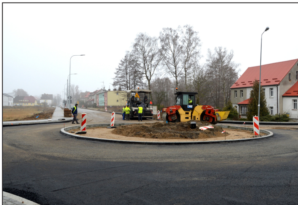
Tak prezentuje się jedno z trzech rond na odcinku drogi 205
