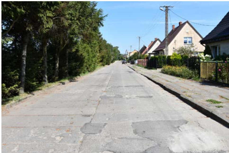
Obecne płyty jumbo na ul. Kosynierów zastąpi nowa nawierzchnia z kostki betonowej
