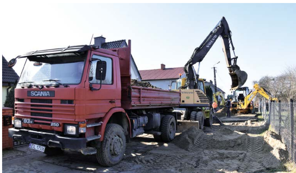
Na obu ulicach wybudowana została nowa kanalizacja deszczowa
