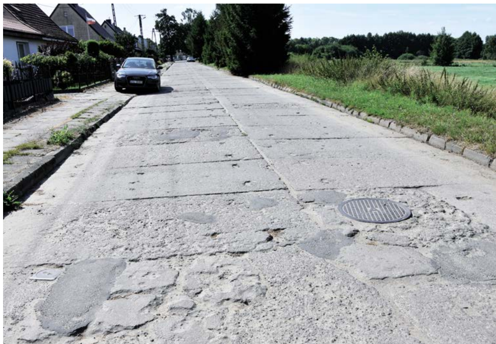
Na ul. Kosynierów zużyte płyty jumbo zastąpiła nowa kostka betonowa
