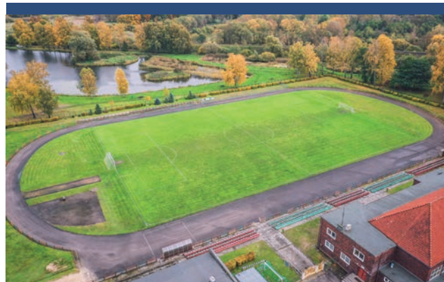
Gruntowna przebudowa Stadionu Miejskiego str. 6
