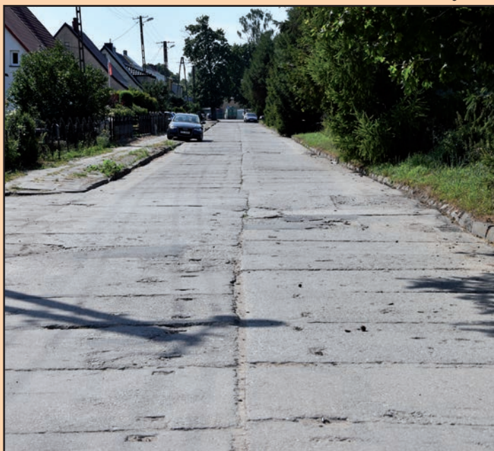
STAN ULICY PRZED PRZEBUDOWĄ
