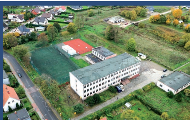
Trwa przebudowa budynku po Szkole Podstawowej nr 1 str. 7
