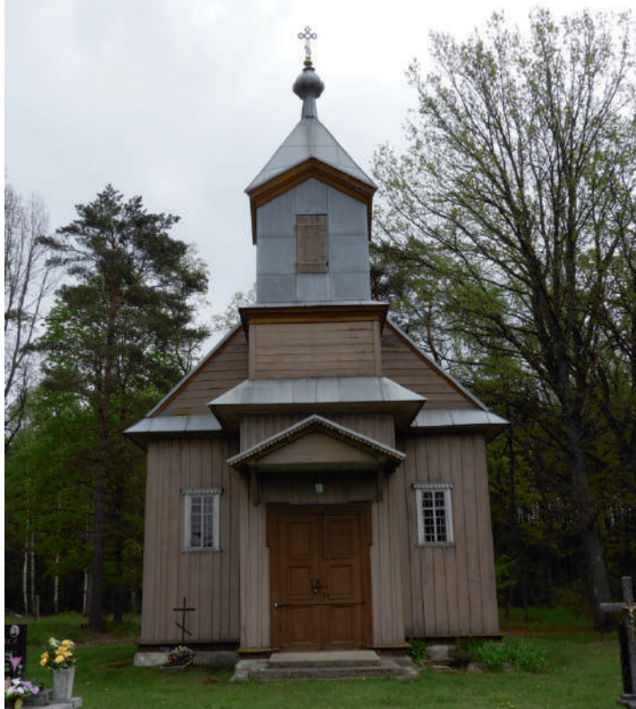
Ryc. 1. Białowieska cerkiew prawosławna z lat 1853-1894, obecnie na cmentarzu w Trześciance. Elewacja frontowa.
