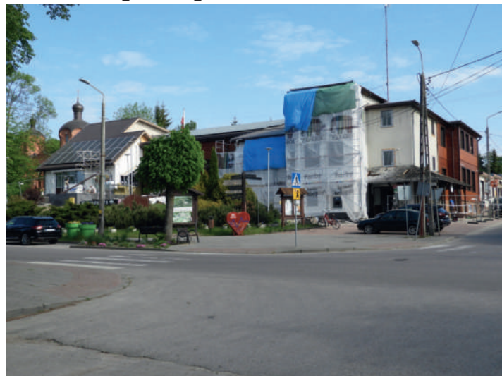
Ryc. 2. Siedziba Urzędu Gminy Białowieża w trakcie termomodernizacji, maj 2023 r.
