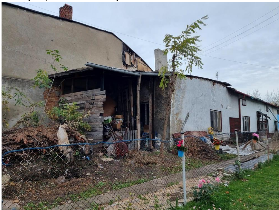
Fotografia 20 Budynki przeznaczone do wyburzenia, Kamieńsk
