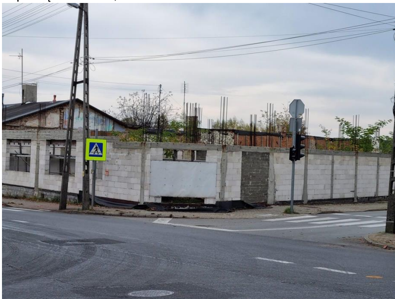
Fotografia 17 Rozpoczęta budowa, centrum Miasta Kamieńsk
