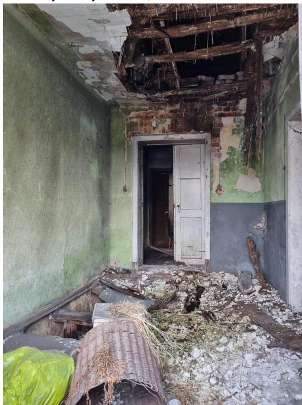
Fotografia 21 Wnętrze kamienicy do wyburzenia, Miasto Kamieńsk
