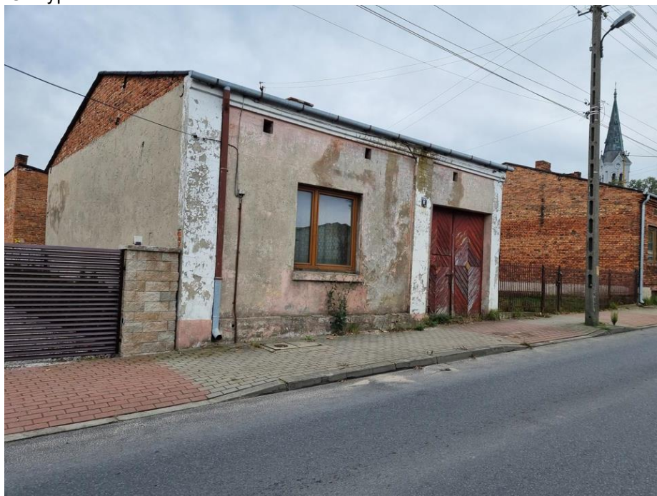
Fotografia 18 Typowe budownictwo w centrum Kamieńska
